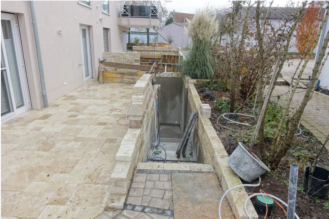
Zugang zum Kellergeschoss des Anwesens Haus Nr. 15a, Ansicht von Westen
