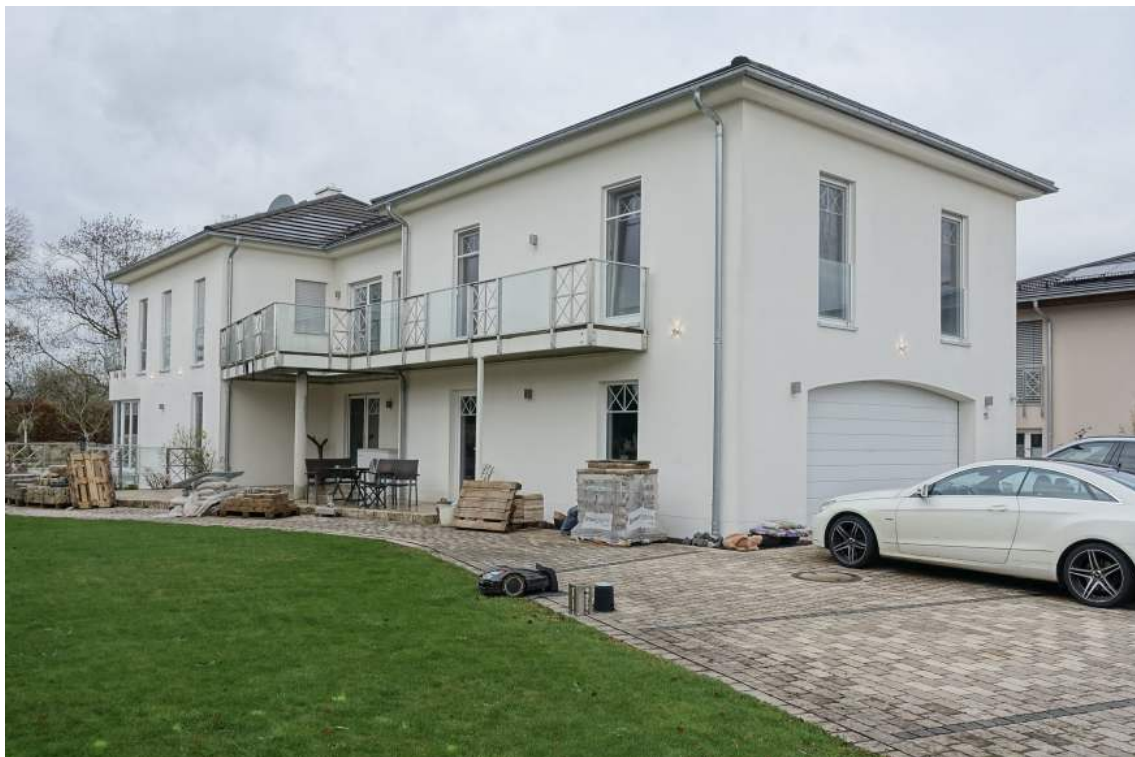
Ansicht von Südosten
