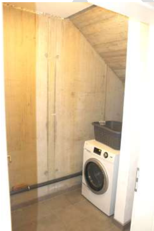
Abb. 24: KG - Abstellraum unter Treppe
