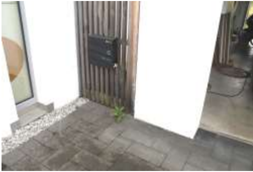
Abb. 35: Durchgang zwischen Garage und Wohnhaus, Briefkasten
