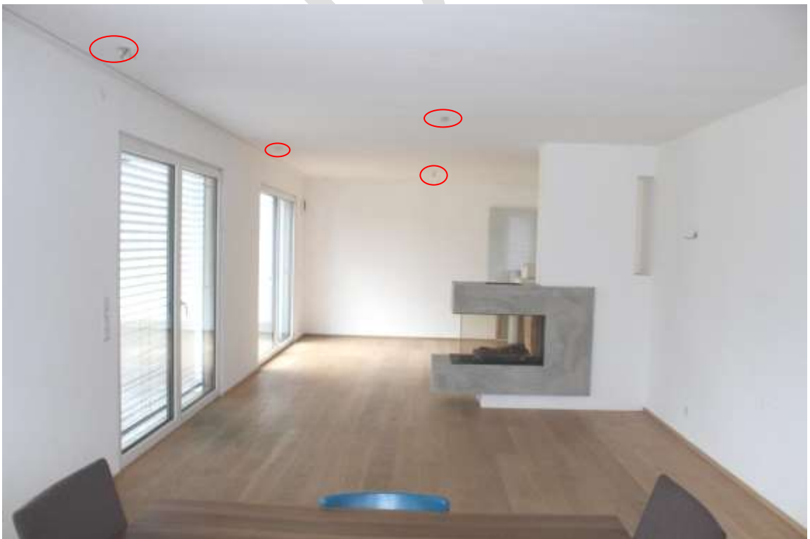
Abb. 10a: Wohnzimmer – Blick nach Westen, fehlende Deckenbeleuchtung
