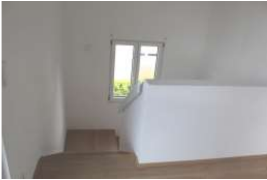
Abb. 15a: Treppe DG – Blick nach unten
