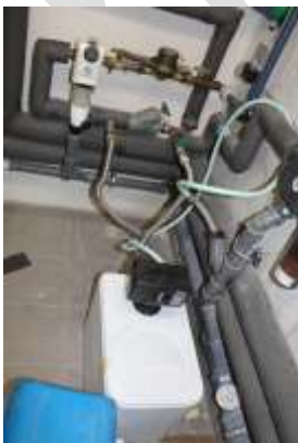
Abb.31c: Wasserenthärtungsanlage
