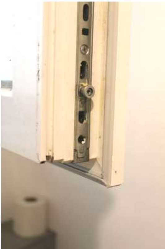
Abb. 33a: Hochwasserschutzfenster
