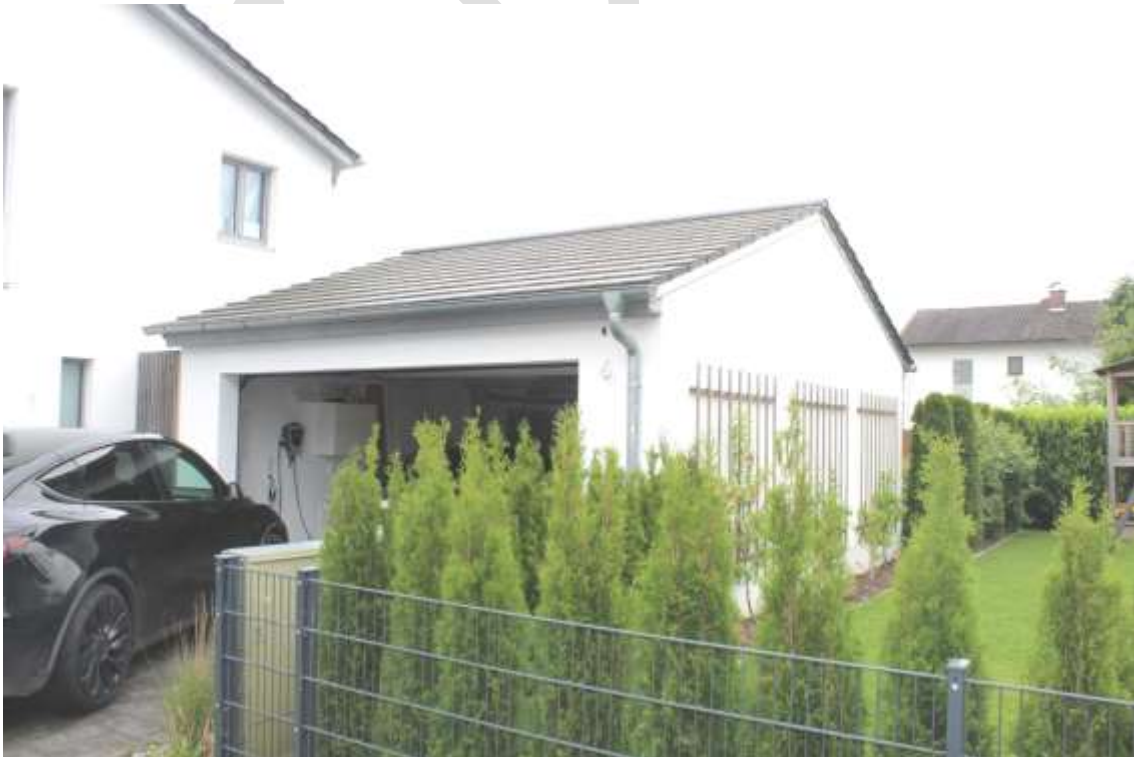
Abb. 5a: Nordwestansicht Doppelgarage
