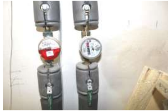
Abb. 31d: Wasserzweischenzähler
