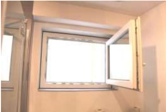
Abb. 33: Hochwasserschutzfenster Bad
