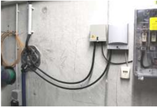
Abb. 31a: Glasfaser vorbereitet, Kommunikationsanschlüsse
