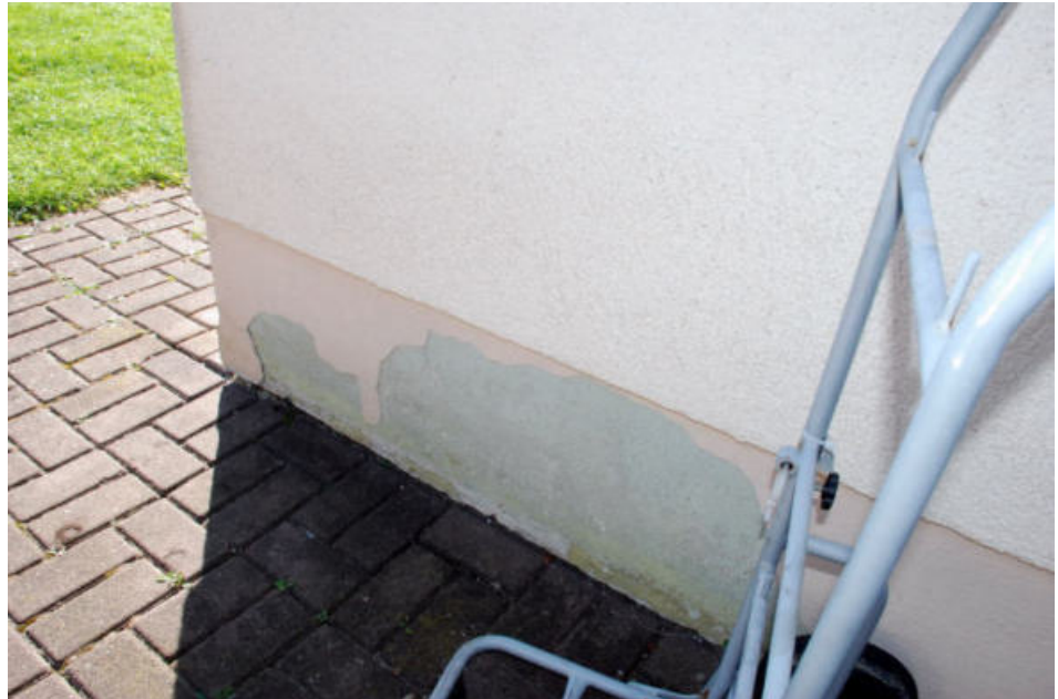
Putz- und Feuchtigkeitsschäden im Sockelbereich am nördlichen Gebäudeteil
