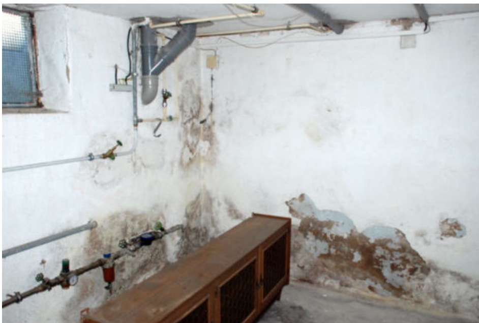
Putz- und Feuchtigkeitsschäden im nördlichen Keller
