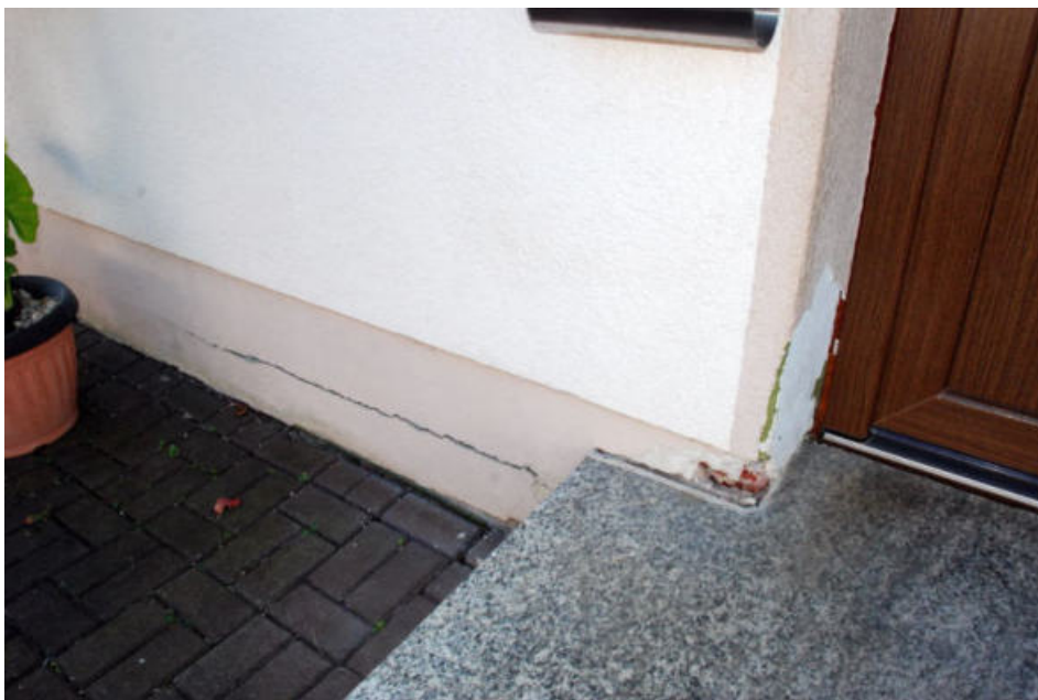
Rißbildung und Putzschäden am Nordgiebel
