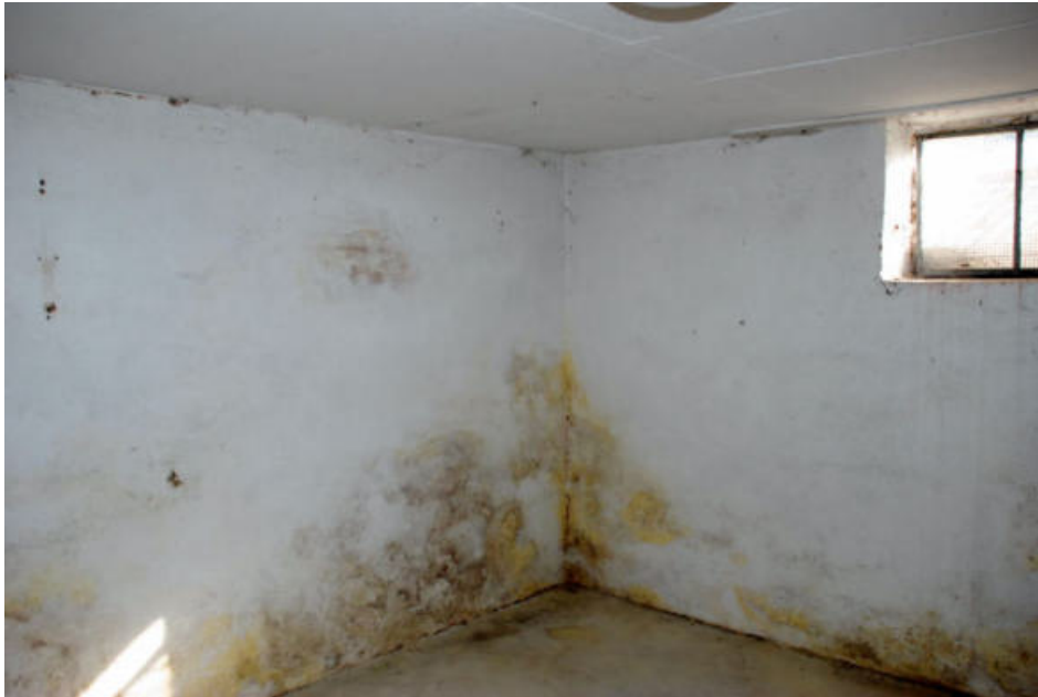
Putz- und Feuchtigkeitsschäden im nördlichen Keller
