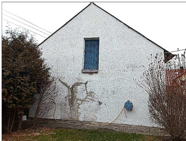
Gebäude D – Giebel Westseite
