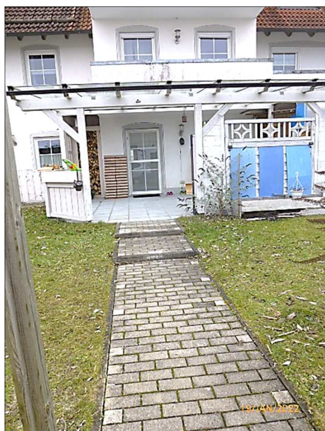
Haus A – Terrasse
