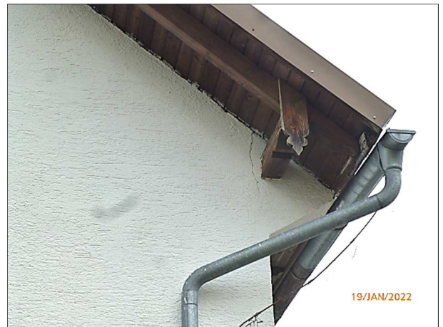
Haus B – Dachvorsprung Giebel
