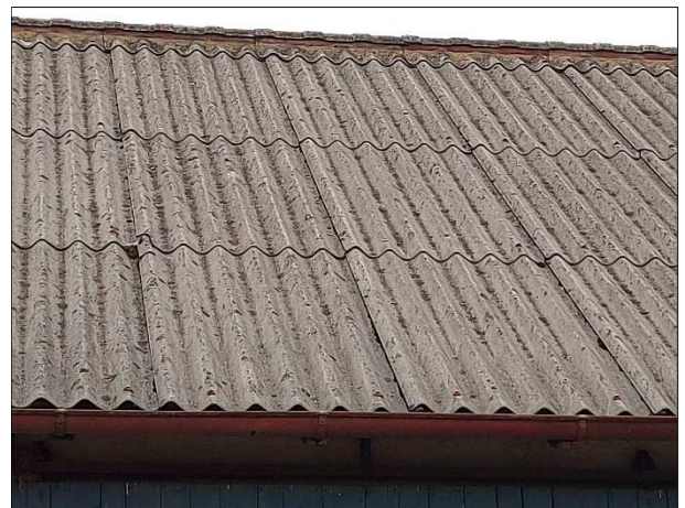
Gebäude D - Welleternitdachdeckung
