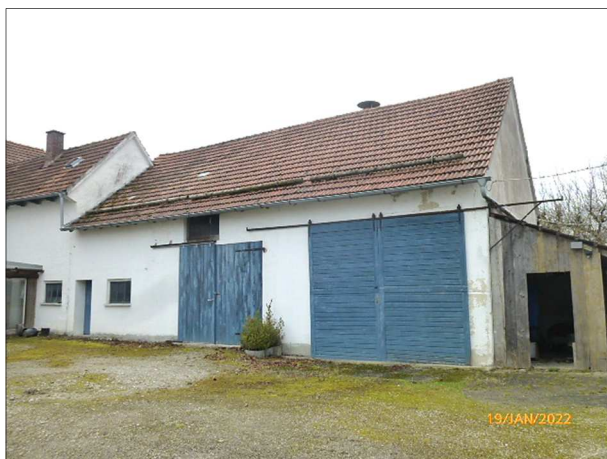
Gebäude C – Hofseite
