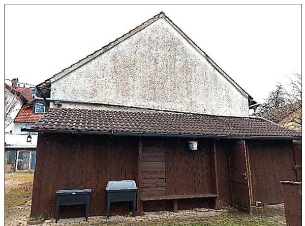
Gebäude C – Giebel und Holzanbau Nordseite
