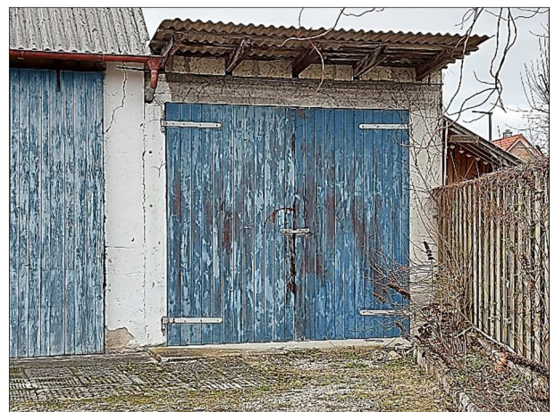
Gebäude D – Anbau Westseite
