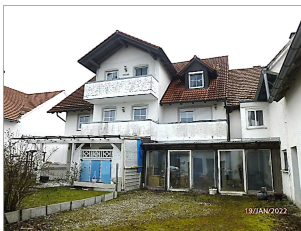
Haus A – Nordseite
