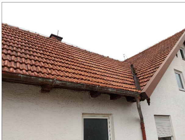
Haus B – alte Dachdeckung
