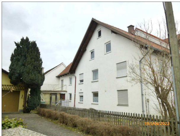
Haus B – Westseite
