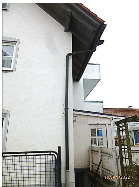
Haus A – Nordostecke
