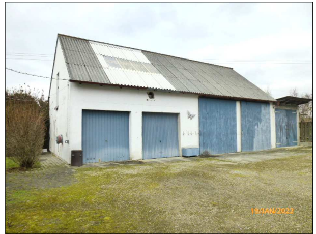
Gebäude D – Südseite
