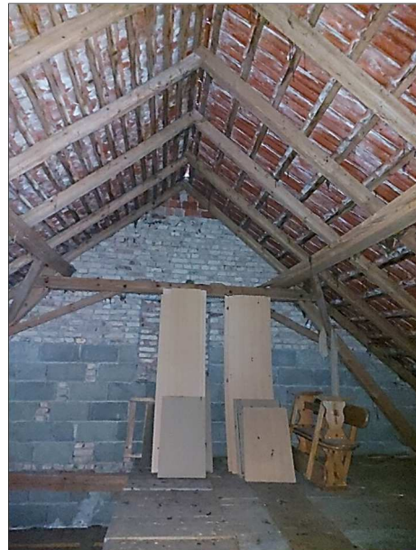
Haus B – alter Dachstuhl
