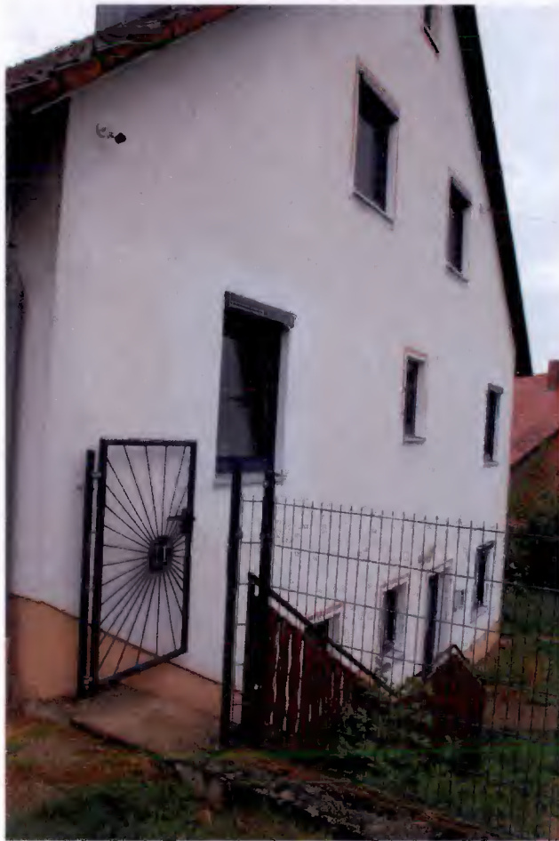
Außentreppe am Ostgiebel
