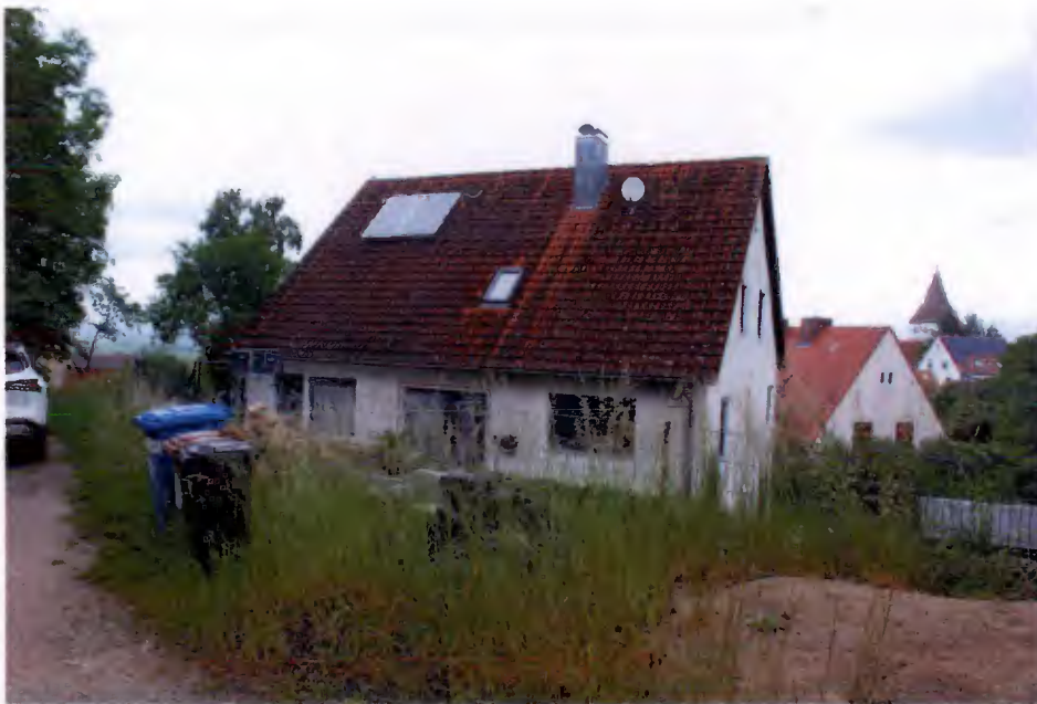
Grundstück FINr.1618 Dorfstraße 40
