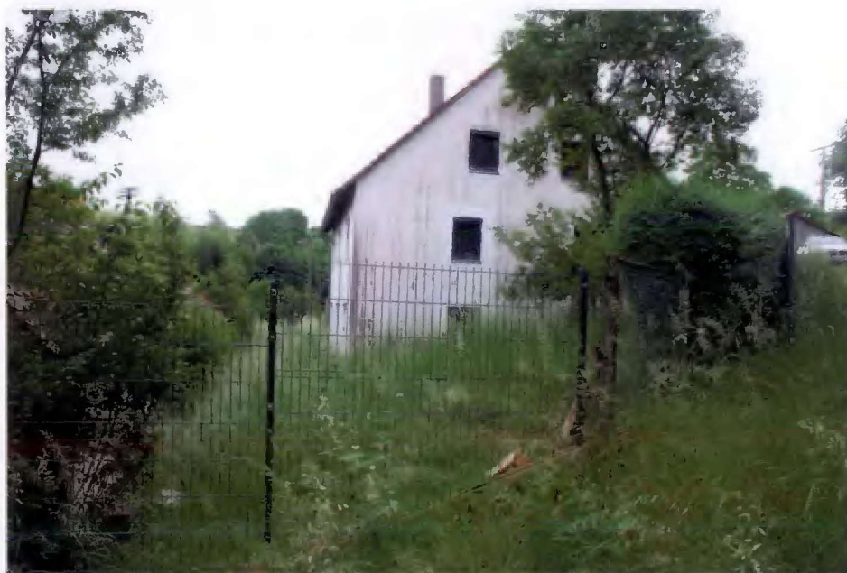
Westgiebel des Wohnhauses
