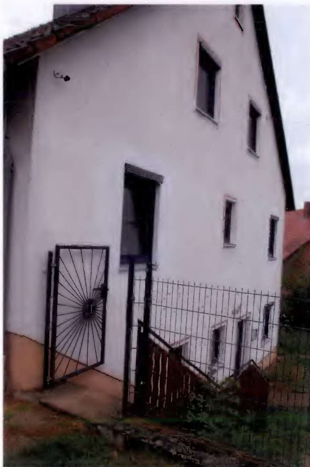
Außentreppe am Ostgiebel
