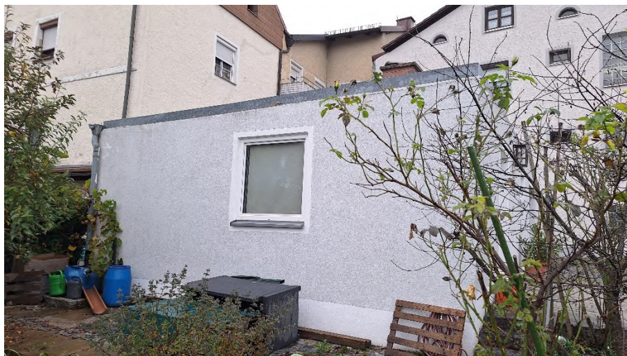
Blick von Südwesten auf das Nebengebäude
