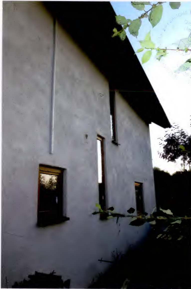
Wohnhaus von Nordosten
