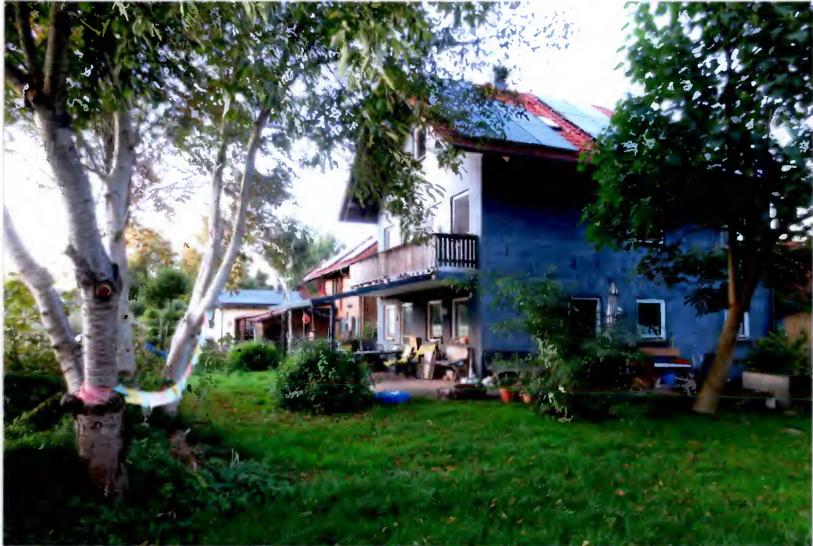
Wohnhaus von Südwesten
