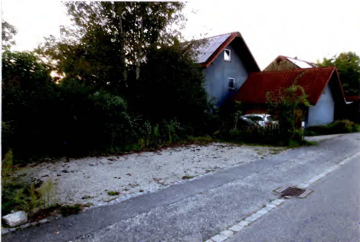
Wohnhaus, Doppelgarage und private Stellplätze von Südosten
