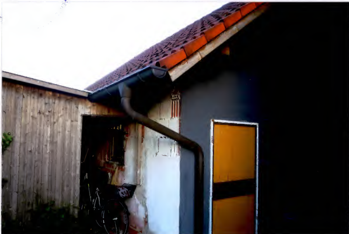
Doppelgarage samt Anbau von Westen
