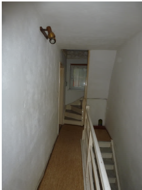
Treppenhaus im OG
