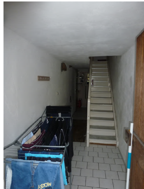
Treppenhaus im EG (Hauptwohnung)
