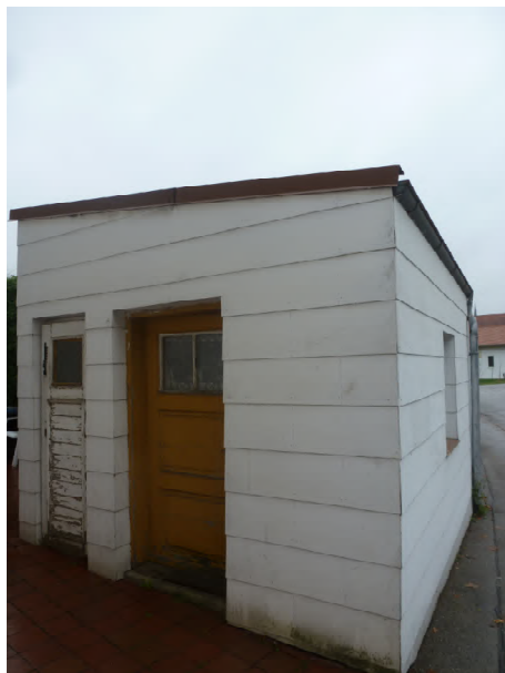
Blick von Norden auf das Nebengebäude
