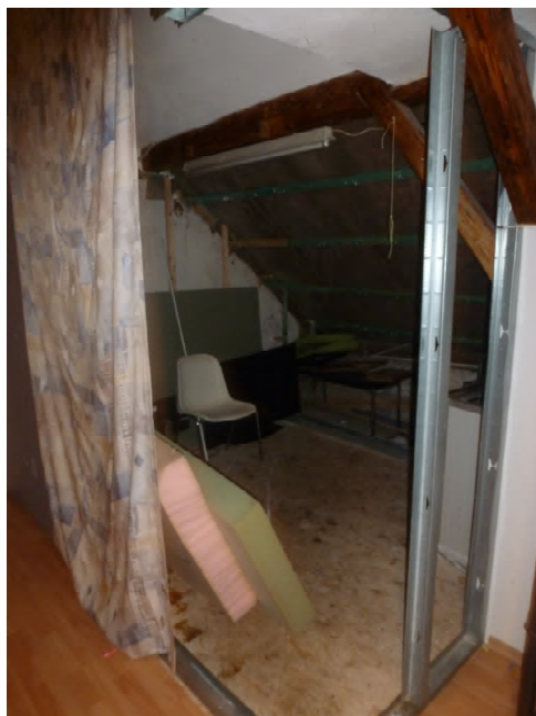
im Ausbau befindliches Zimmer im DG
