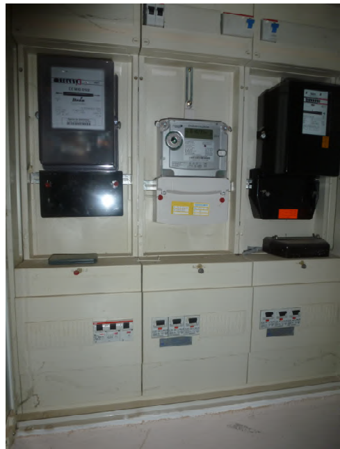
erneuerte Elektrohauptabsicherung
