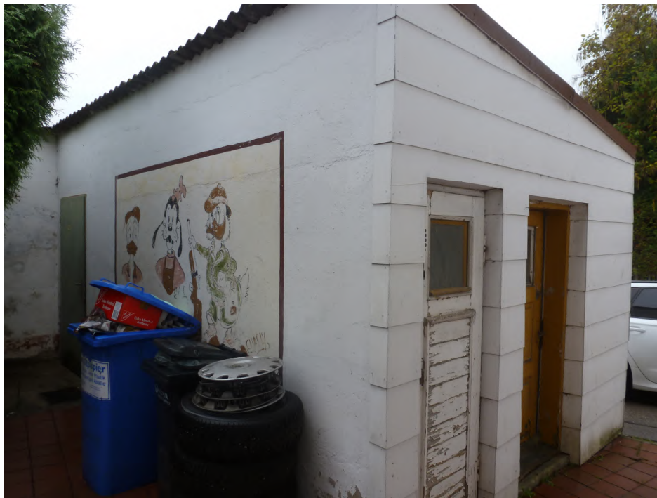
Blick von Nordosten auf das Nebengebäude
