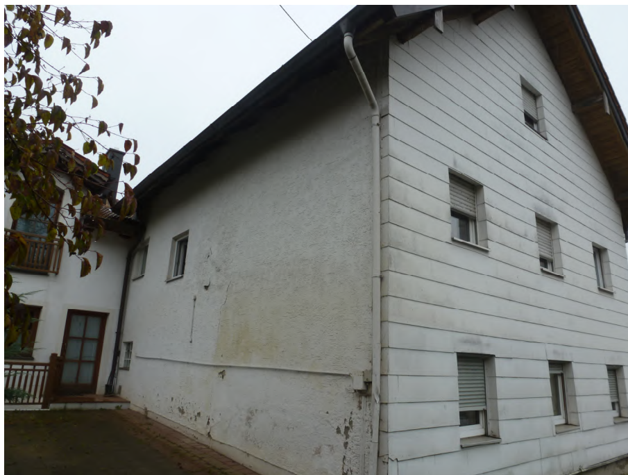
Blick von Nordwesten auf das Wohngebäude
