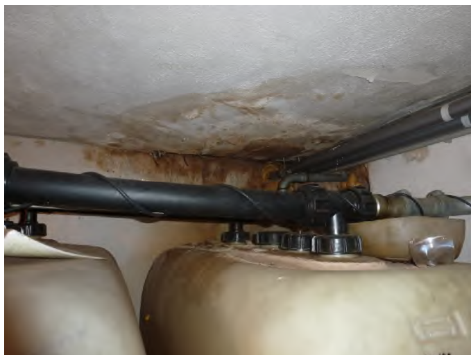
Feuchtigkeitsschäden Deckenuntersicht Heizraum
