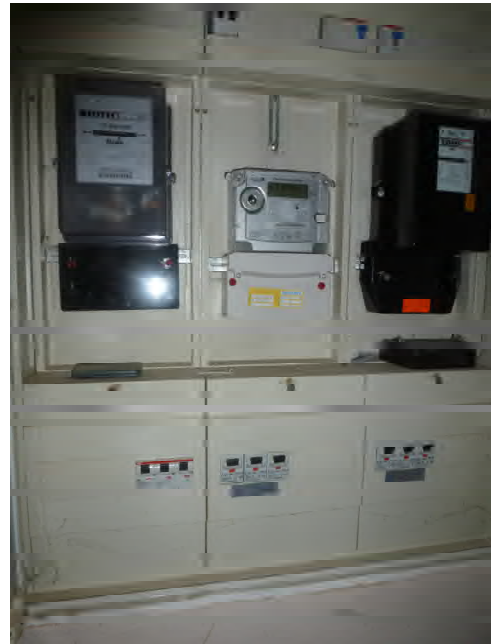
erneuerte Elektrohauptabsicherung
