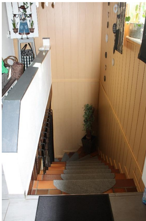
Vom Erdgeschoss in das Kellergeschoss führt diese geflieste Massivtreppe mit aufgelegten Teppichbodensegmenten.
