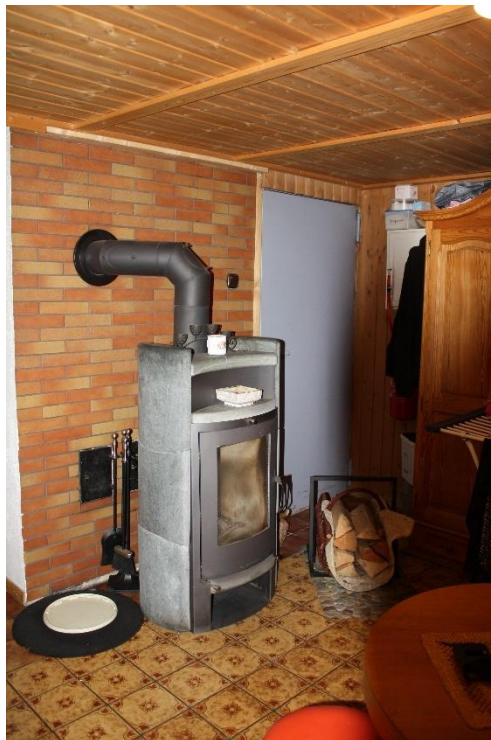
der Ofen für zusätzliche Wärme- gewinnung im Kellergeschoss
