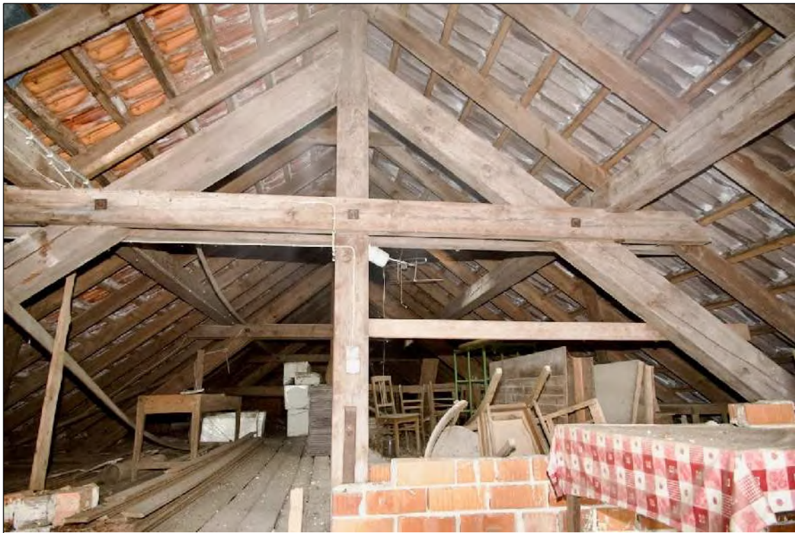
Foto 17 Nicht ausgebauter Dachraum
