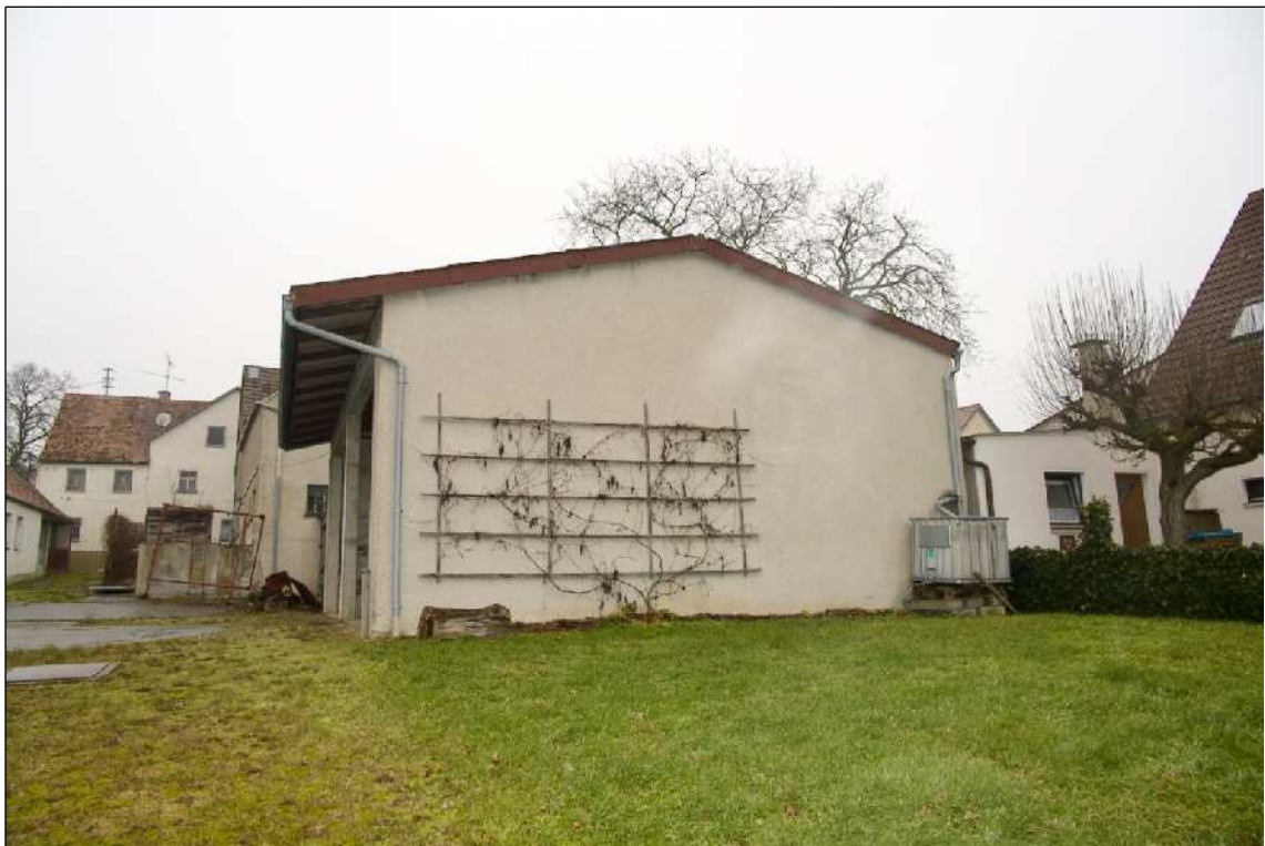
Foto 32 Maschinenhalle - Ansicht von Süden
