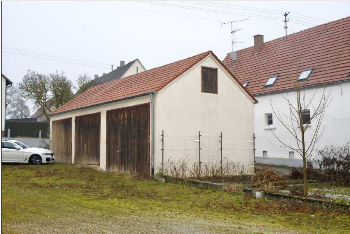
Foto 23 Maschinengarage - Ansicht von Süd-Westen
