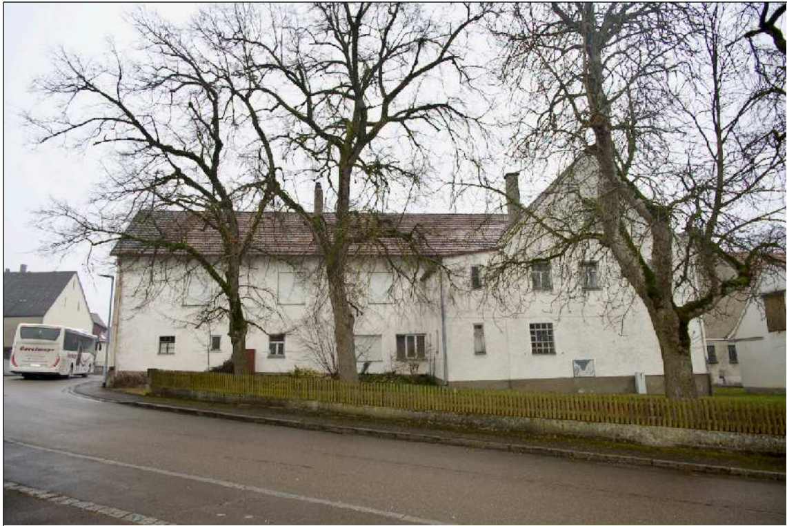
Foto 3 Wohnhaus mit Gaststube, Tanzsaal und Stall - Ansicht von Westen
