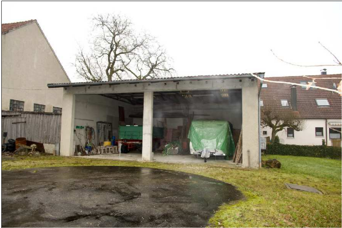
Foto 31 Maschinenhalle - Ansicht von Westen
