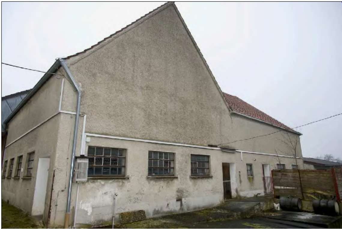
Foto 27 Stall / Scheune - Ansicht von Westen
