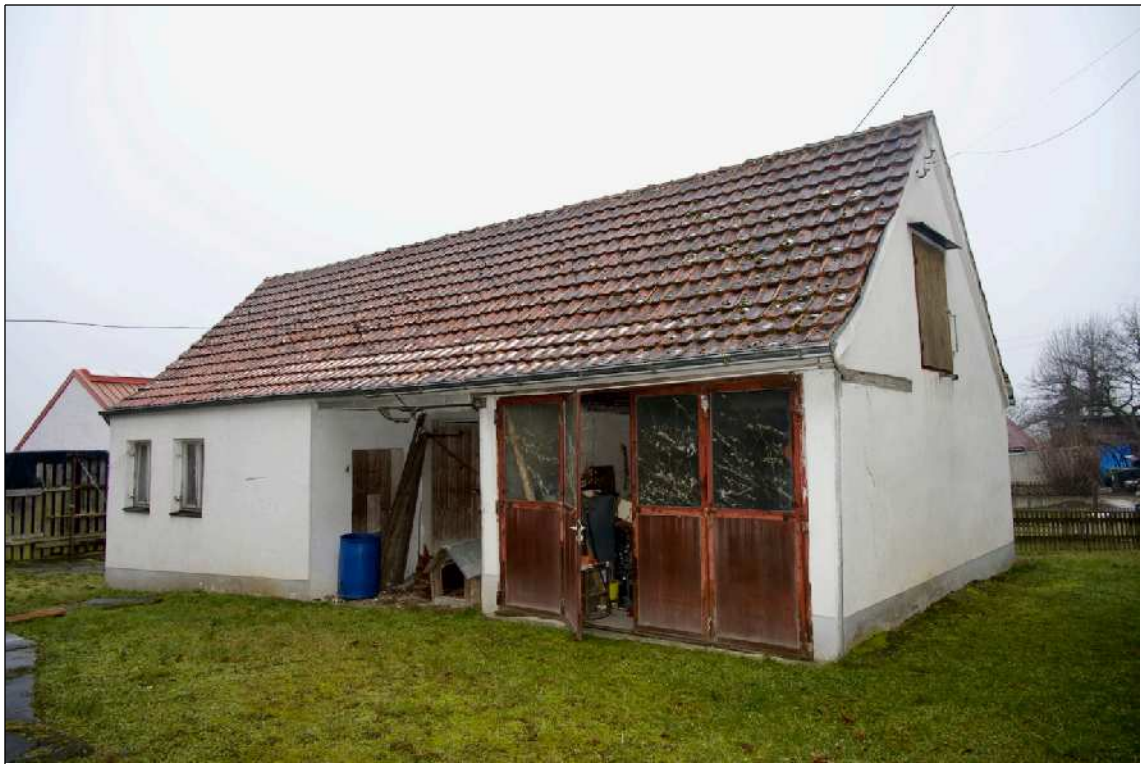
Foto 19 Nebengebäude - Ansicht von Osten
