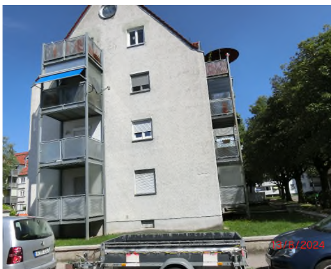
Westfassade Kopfbau MFH Kolbergstraße 6 (Standort Hippelstraße)
