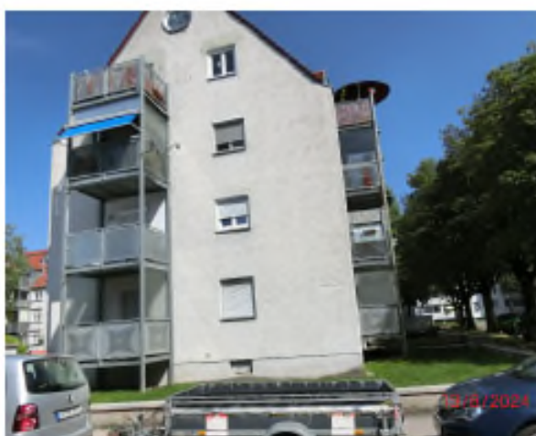
Westfassade Kopfbau MFH Kolbergstraße 6 (Standort Hippelstraße)
