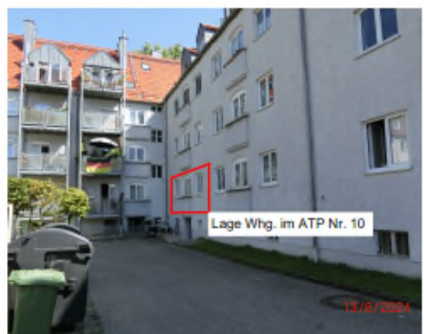
Blick in den Innenhof entlang Nordfassade MFH Nr. 4 und 6
