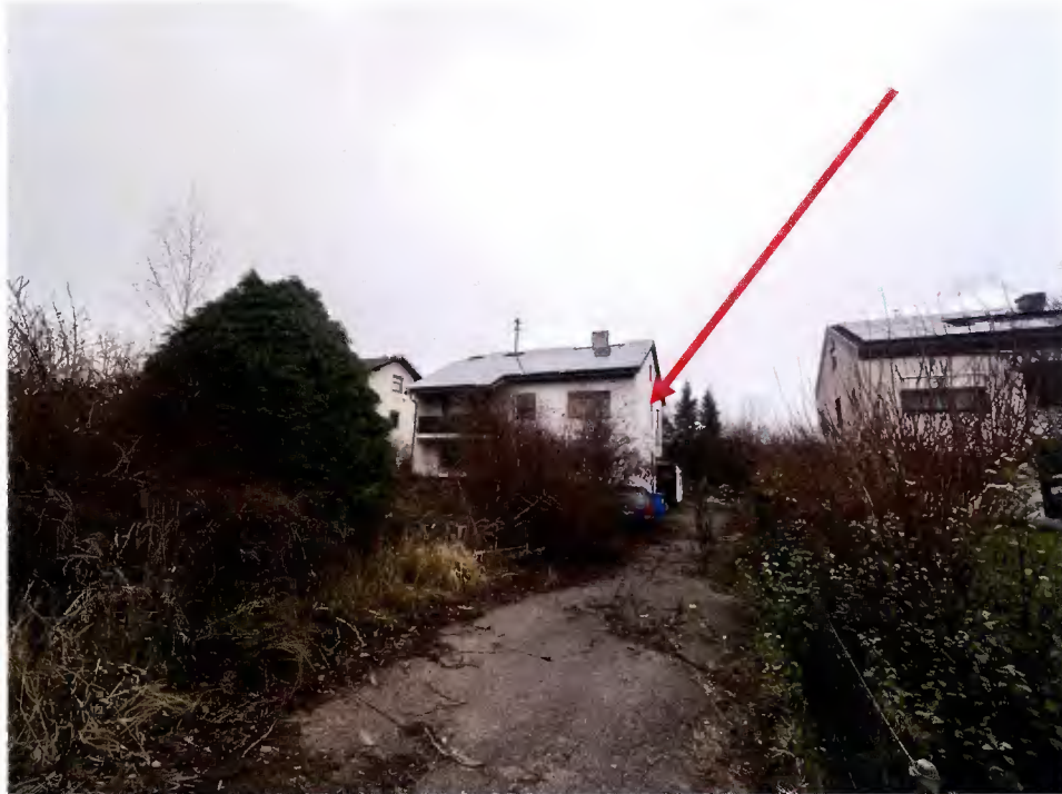
beispielhafte Ansicht der Südseite des Zweifamilienhauses – Münchner Straße 118 mit Zufahrt
