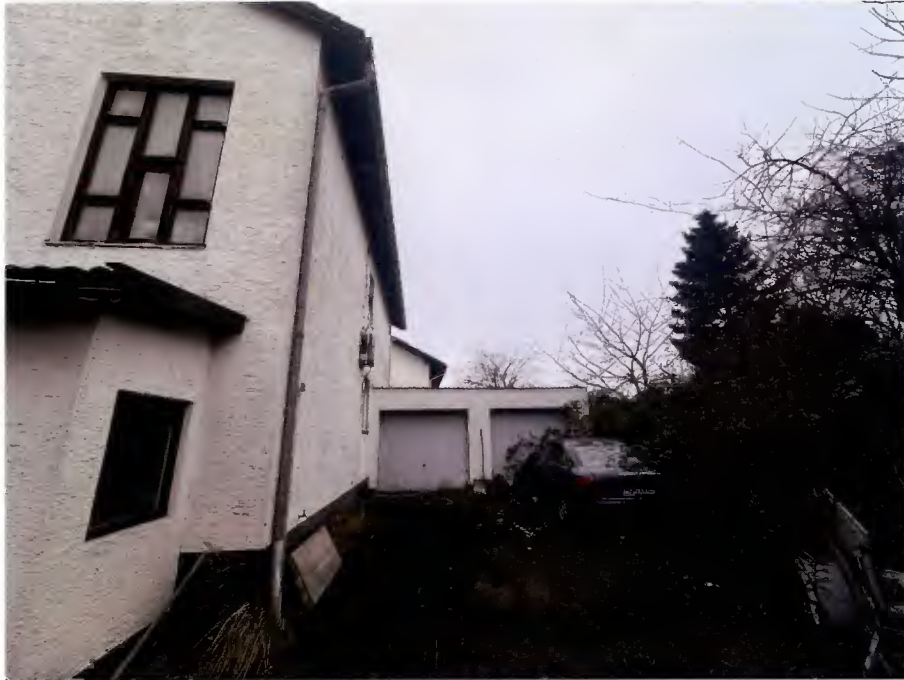
beispielhafte der Nordseite des Zweifamilienhauses mit Doppelgarage
