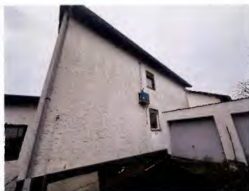
beispielhafte Ansicht der Fenster auf der Gebäude-Nordseite
