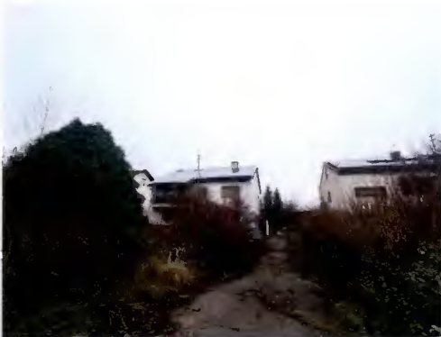
beispielhafte Ansicht der brüchigen Asphaltdecke im Zufahrtsbereich
