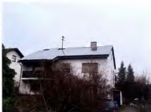
beispielhafte Ansicht der Südseite der Fassade
