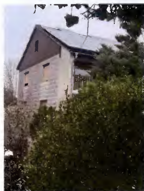
beispielhafte Ansicht der Westseite der Fassade
