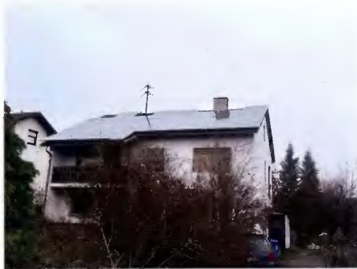
Ansicht der Südseite des Zweifamilienhauses
