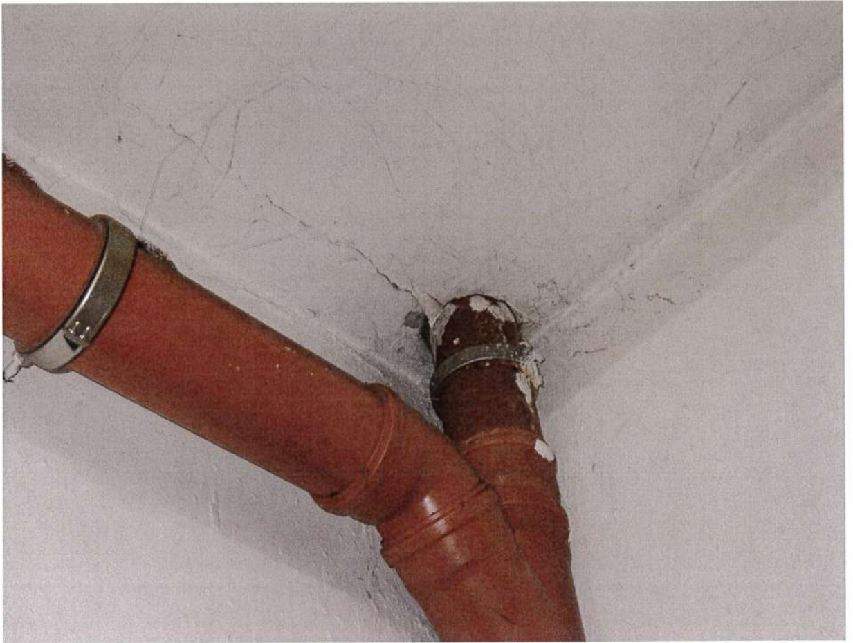
Abbildung (27) Decke im EG-Lagerraum
