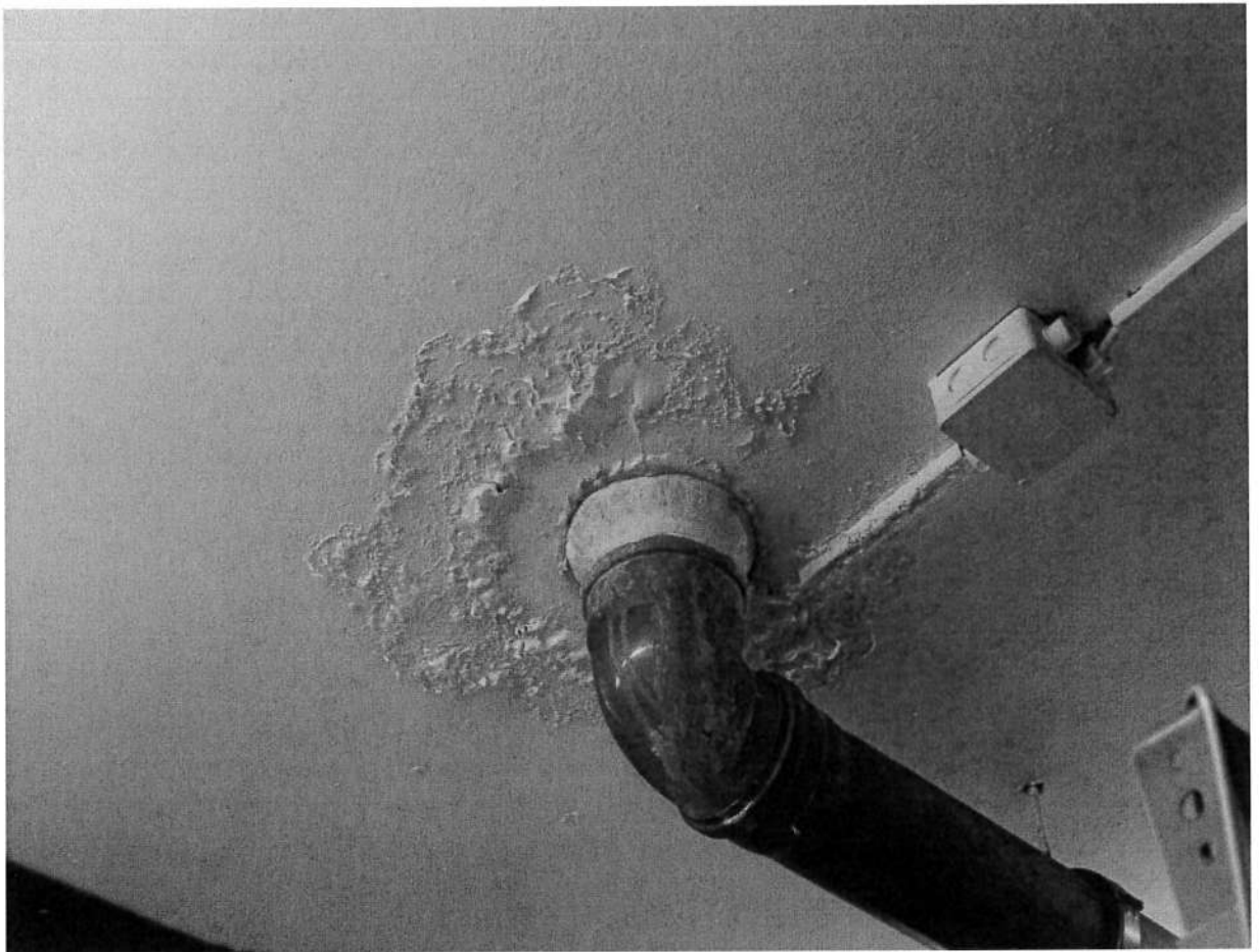
Abbildung (26) Decke im EG-Lagerraum
