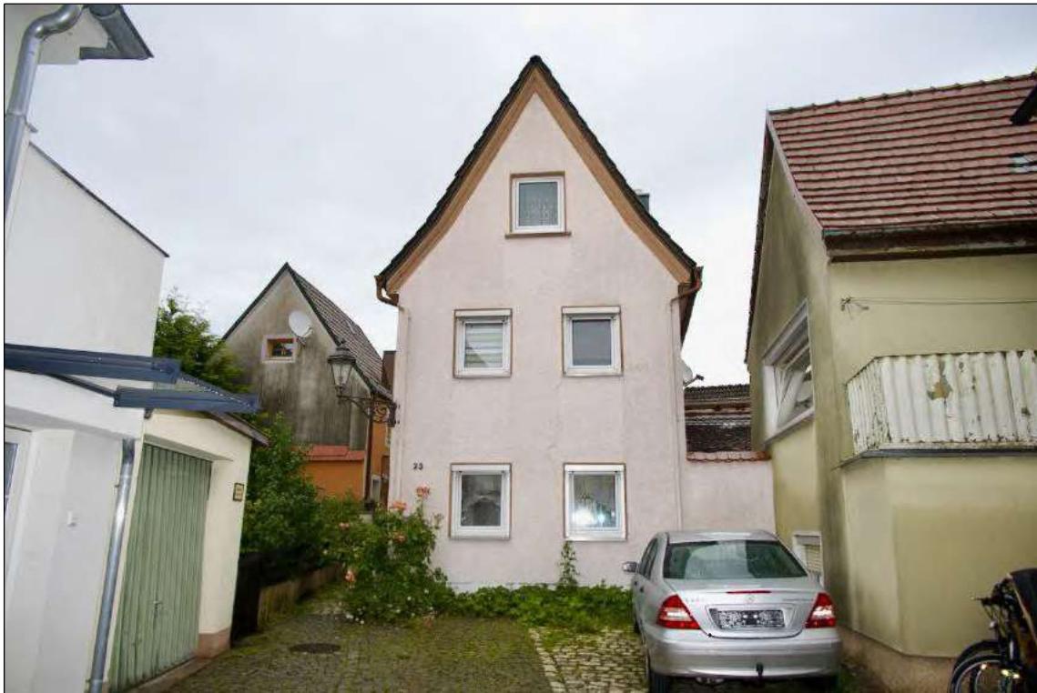
Foto 1 Ansicht von Westen
