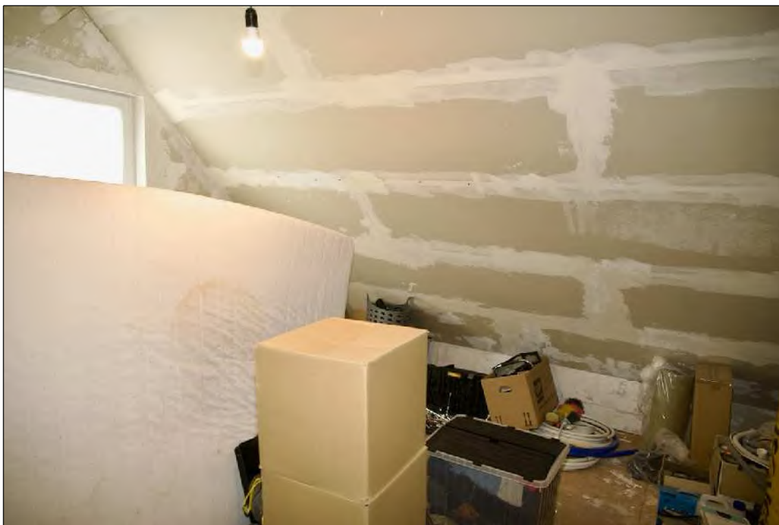
Foto 13 Sondereigentum 1 - Dachgeschoss, Wohnraum (nicht fertiggestellt)
