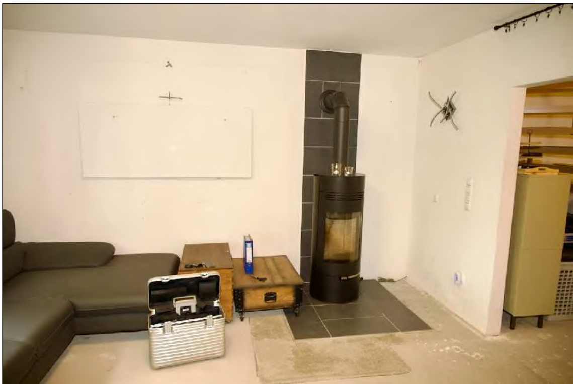
Foto 6 Sondereigentum 1 - Erdgeschoss, Wohnraum
