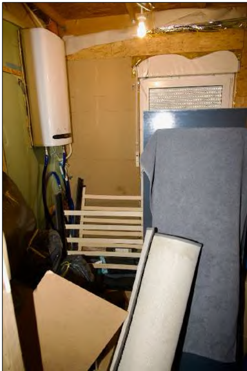
Foto 14 Sondereigentum 1 - Dachgeschoss, Bad (nicht fertiggestellt)
