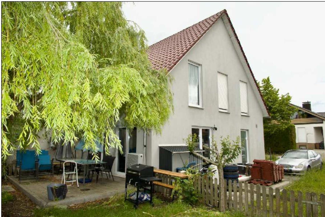
Foto 3 Ansicht von Osten
