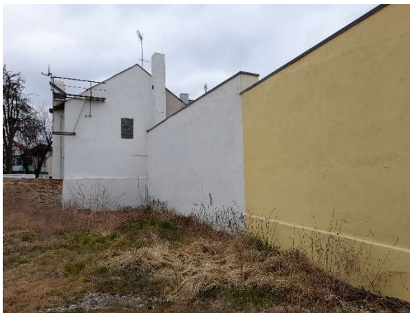
Bewertungsgrundstück – Grenzbebauung Nordseite
