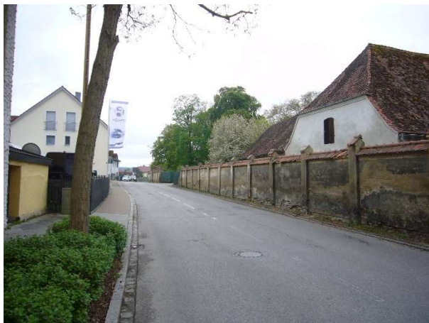
Aichacher Straße – Blickrichtung Süden
