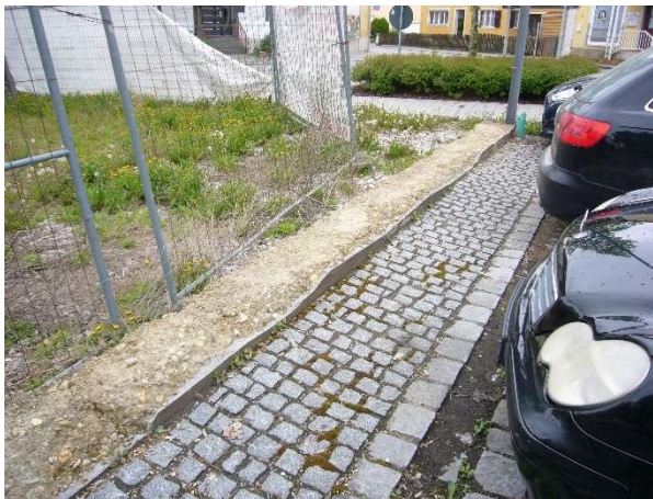
Bewertungsgrundstück Südseite mit öffentlicher Parkplatz und altes Fundament Bauernhaus
