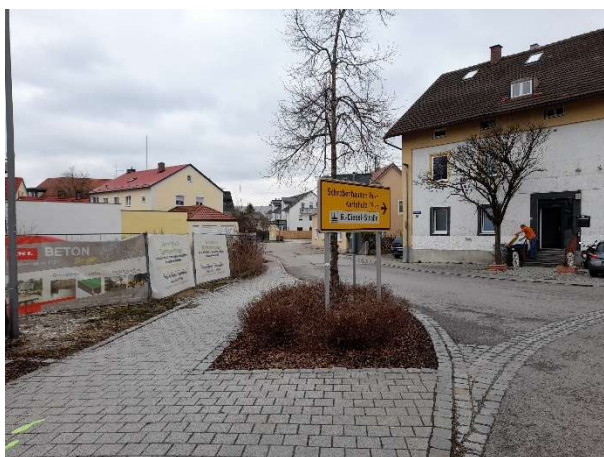
Verkehrsknotenpunkt - Erneuerter Gehweg
