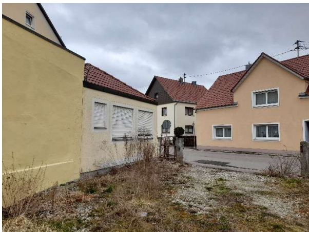
Bewertungsgrundstück – Auffahrt NO-Ecke mit Grenz-Bebauung Geschäftshaus
