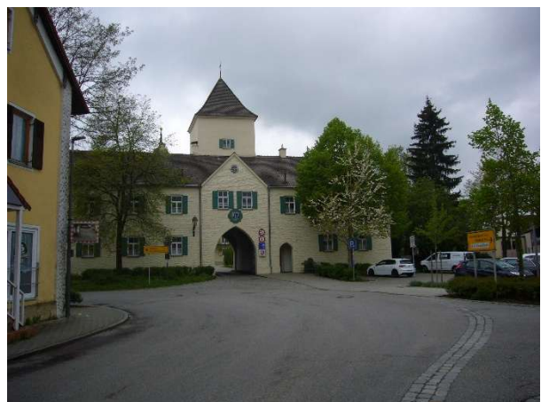
Verkehrsknotenpunkt - Blickrichtung Südwesten
