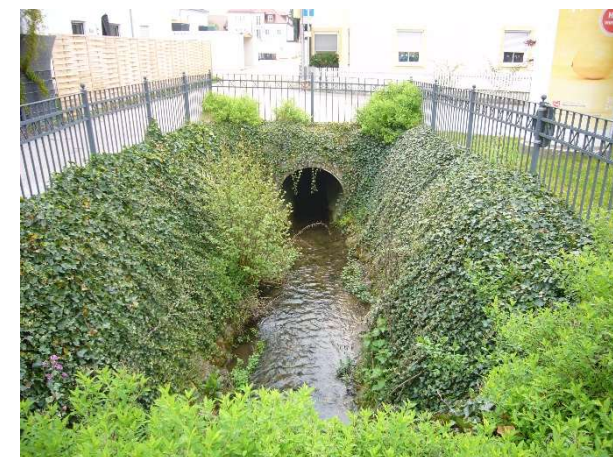
teilweise verrohrter Schimmelwiesbach
