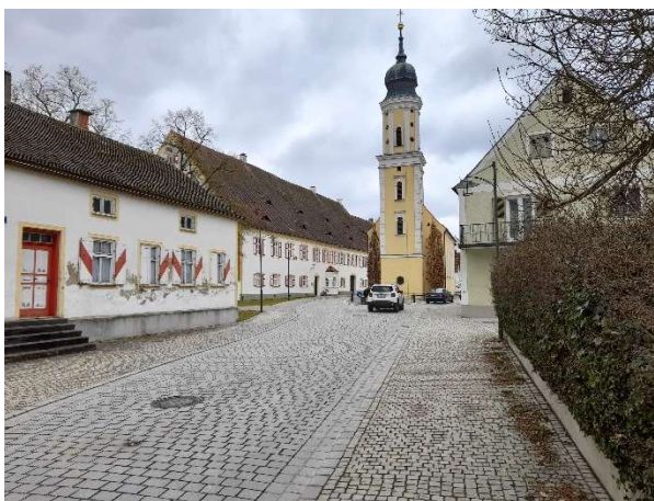
Marktplatz – Blickrichtung Südwesten – Hinter der Einfahrt Unteres Tor
