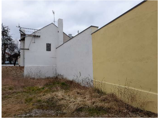
Bewertungsgrundstück – Grenzbebauung Nordseite
