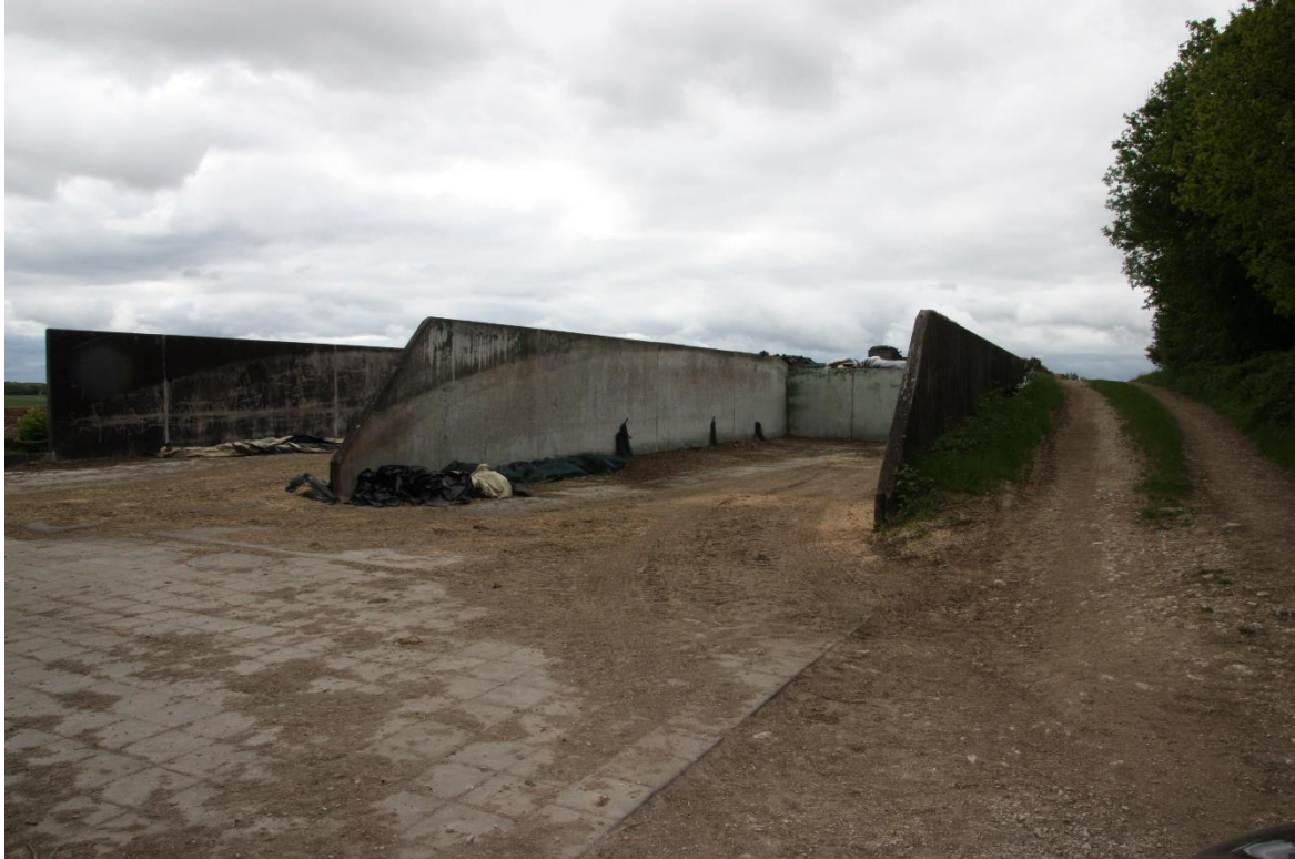
Flst. Nr. 369: Remise
