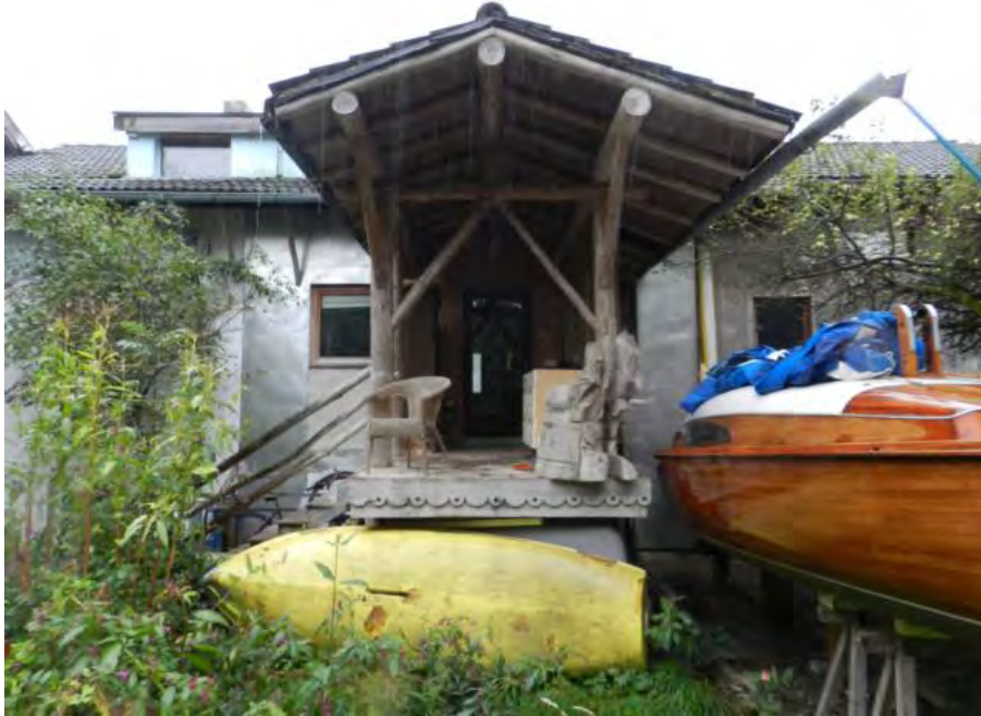
Ansicht Nordfassade; Hauseingang auf Ebene EG
