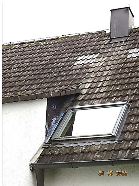
Dachdeckung Betonpfannen ca. 1984
