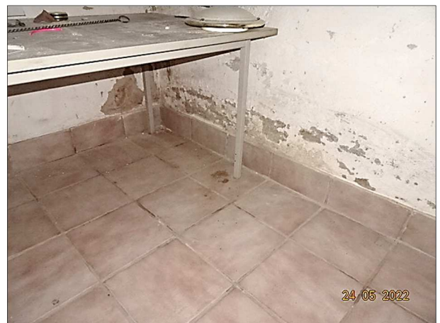
Feuchtigkeitsschäden Kellerraum
