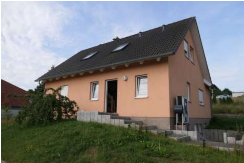
Bild 2: Straßenseite des Bewertungsobjekts
