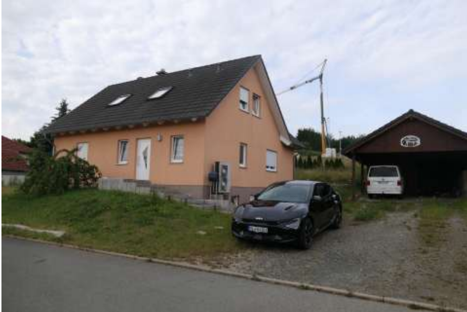
Bild 1: Straßenseite des Bewertungsobjekts
