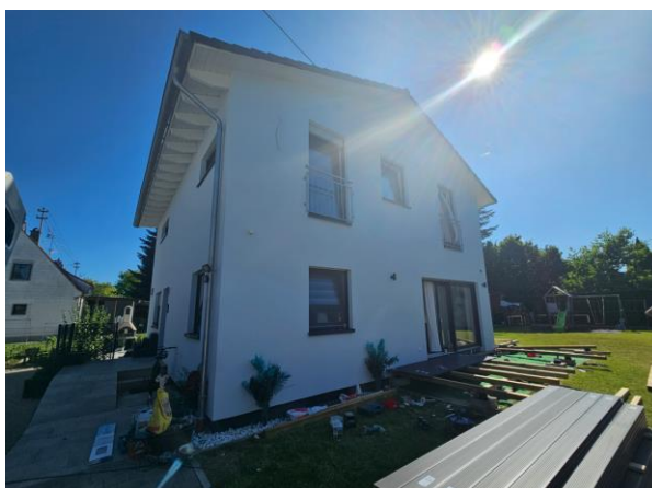
Ansicht Nordost (Terrasse nicht fertiggestellt)
