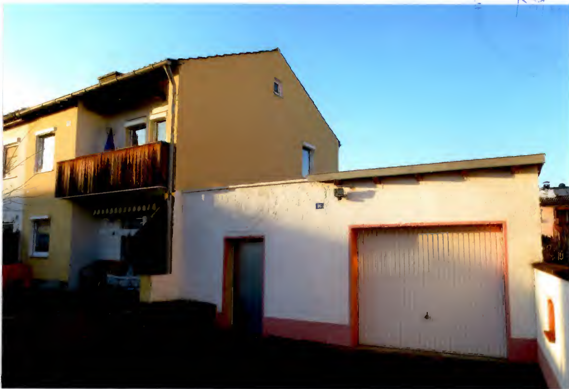
Wohnhaus und Garage von Südosten
