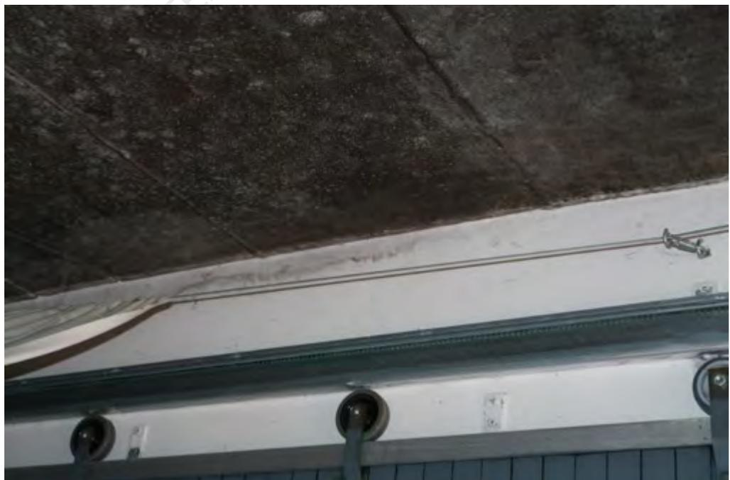
Massive Feuchtigkeitsschäden Garagendecke (undichtes Dach)
