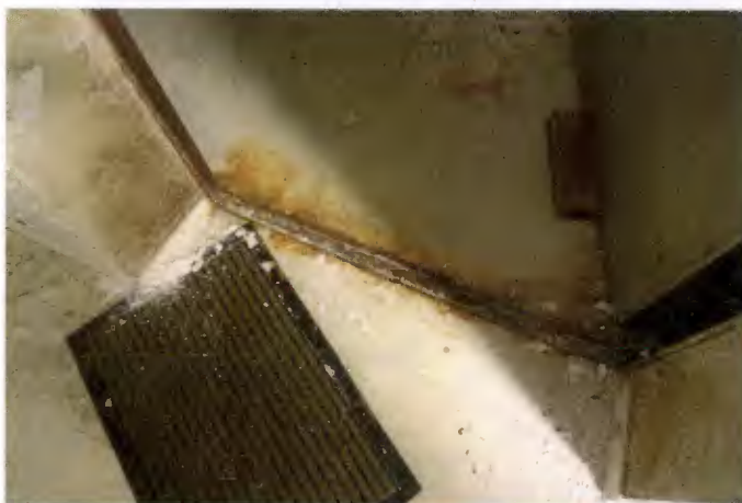
Korrodierte Türzarge
