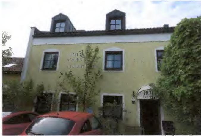
Nordseite mit Eingangsbereich
