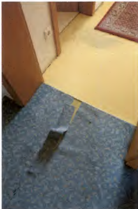
Schadhafte Bodenbelege in OG und DG
