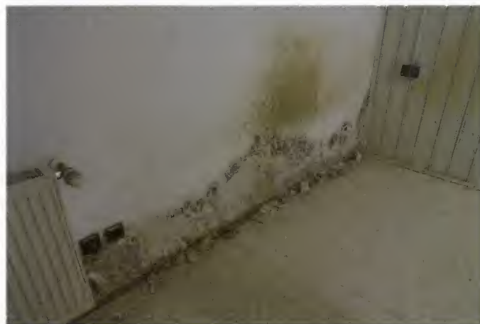
Wasserschaden in Kellerraum
