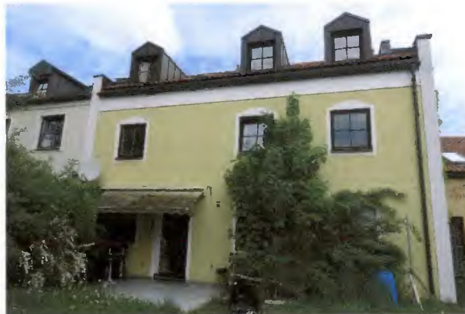
Südseite mit Terrasse
