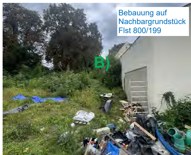
mit Grenzbebauung des Nachbargrundstücks Flst 800/199
