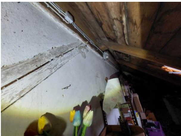
schadhafte Dachschalung
