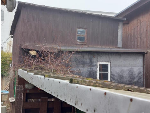
kleine Scheune und Holzlege
