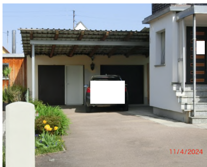
Garagegebäude mit nachträglich errichteter carportähnlicher Konstruktion
