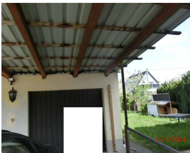
Durchgang zwischen WH und Garagegebäude ...
