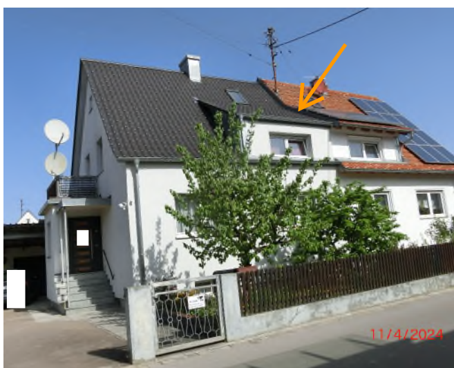
SO-Fassade DHH auf Bewertungsgrundstück Flst. 304/3
