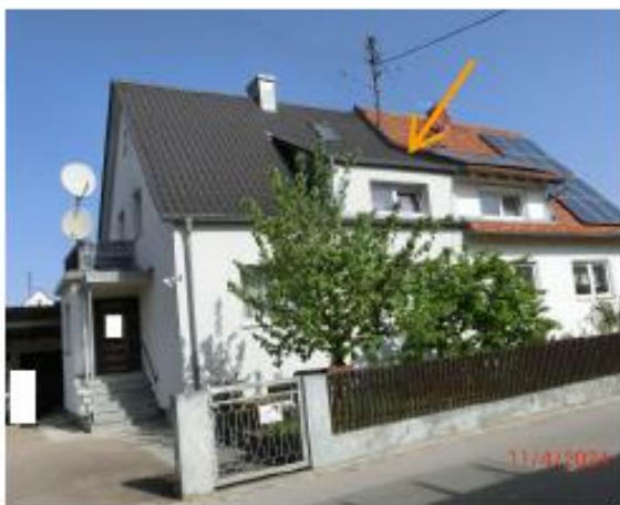
SO-Fassade DHH auf Bewertungsgrundstück Flst. 304/3
