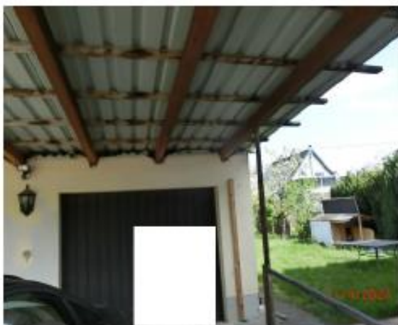
Durchgang zwischen WH und Garagegebäude ...
