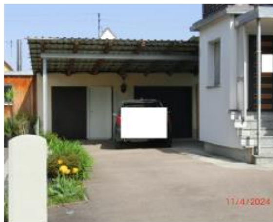
Garagegebäude mit nachträglich errichteter carportähnlicher Konstruktion
