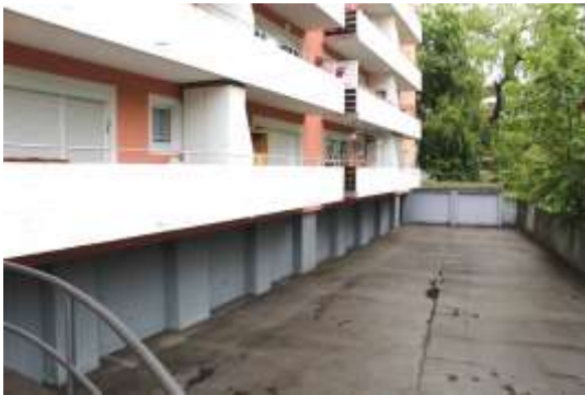
Abb. 5: Hoffläche, Garagen Ostseite
