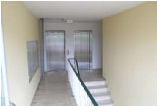
Abb. 11: 5. OG – Lifte, Treppenhaus
