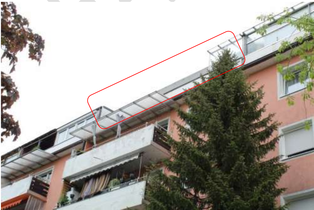
Abb. 2: Ungefähre Lage der Dachterrasse des Bewertungsobjekts - Westseite
