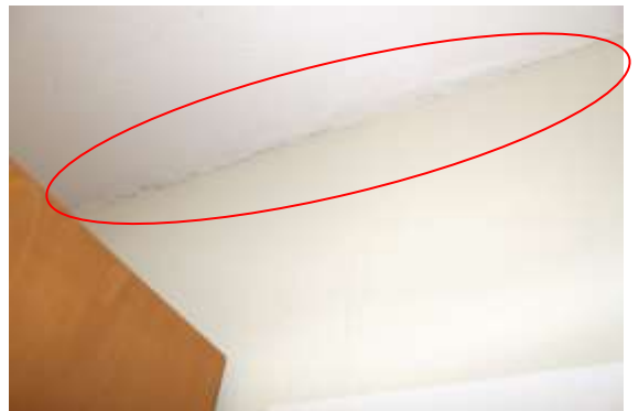
Abb. 22c: Schwund- und Setzrisse - beispielhaft
