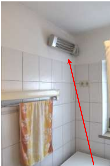
Abb. 15c: Bad/WC – Heizstrahler
