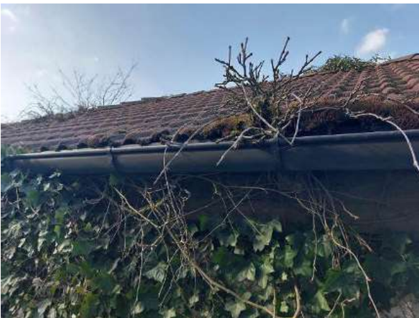
ins Dach eingewachsener Efeu
