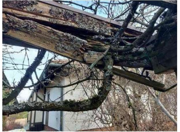
defektes Konstruktionsholz
