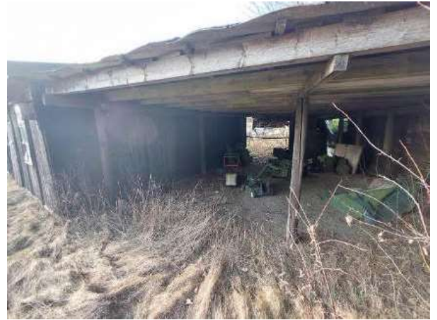
Scheune mit Freiflächenüberdachung Süd-Ost-Ansicht
