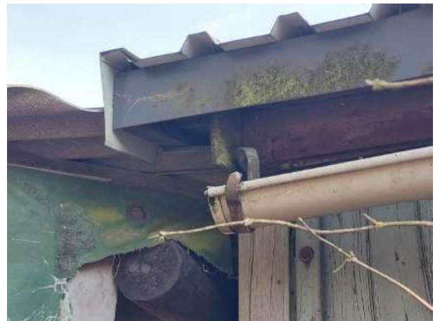
schadhafte Entwässerung
