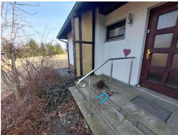
Haustür mit Podesttreppe
