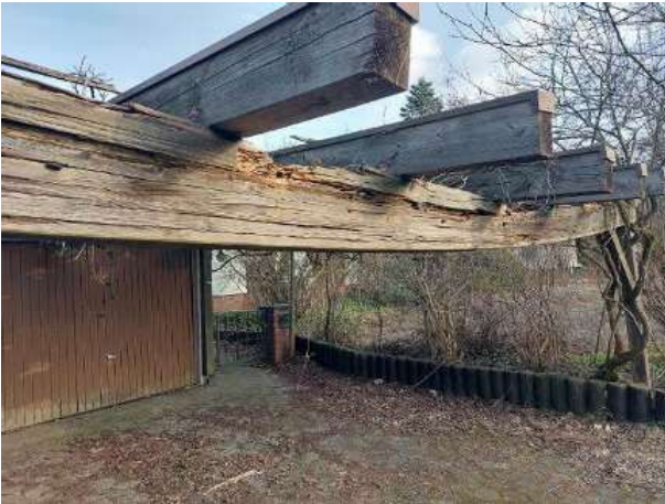
defektes Konstruktionsholz
