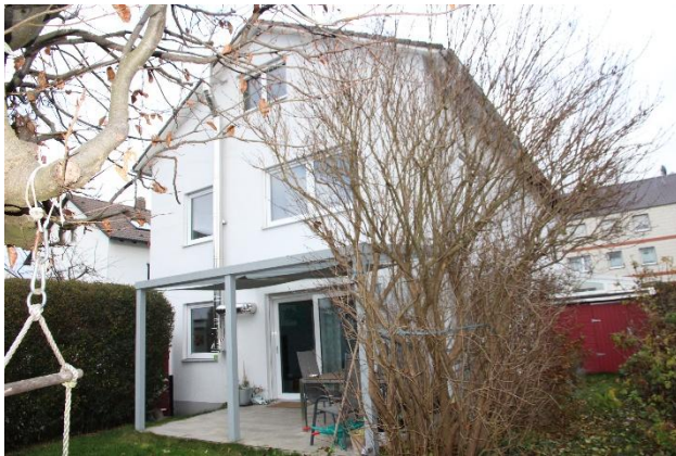
Außenansicht: Doppelhaushälfte von Nordosten
