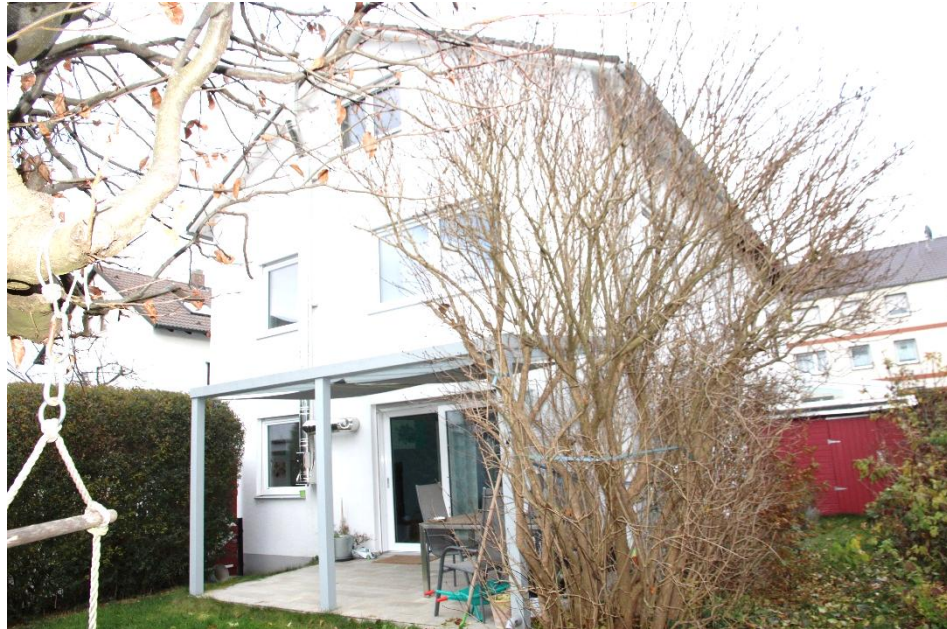
Außenansicht: Doppelhaushälfte von Nordosten
