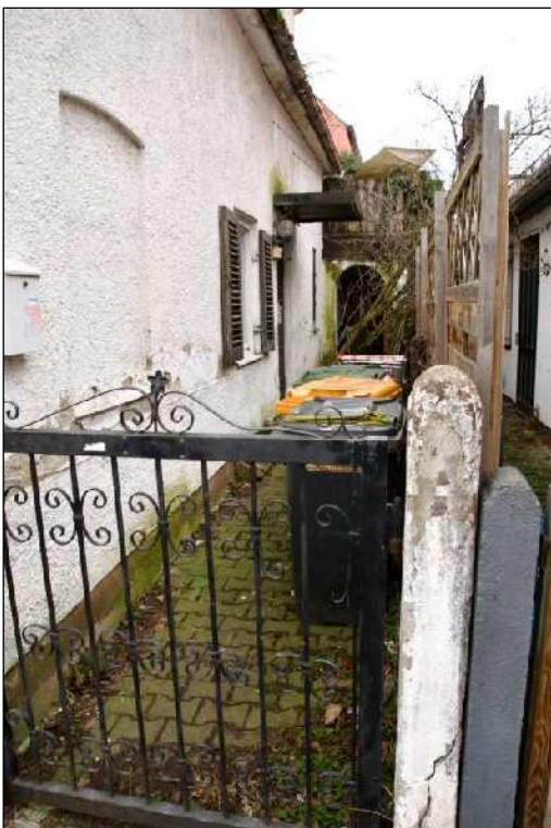
Foto 2 Zugang von der Flurstraße
