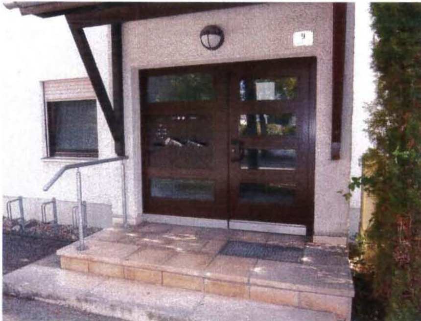
Abbildung(3) Nordwestfassade des Blockgebäudes Hs.Nr. 9 mit Blick auf den Hauseingang.
