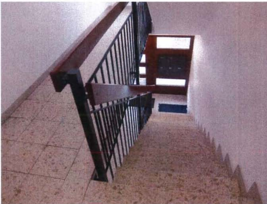
Abbildung Blick auf Hauseingang im Erdgeschoss des Hauses Graslitzer Straße
