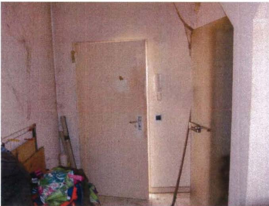
Abbildung(12) Flur mit Eingangstüre im Hobbyraum Nr. 18 im Dachgeschoss des Hauses Nr. 9.
