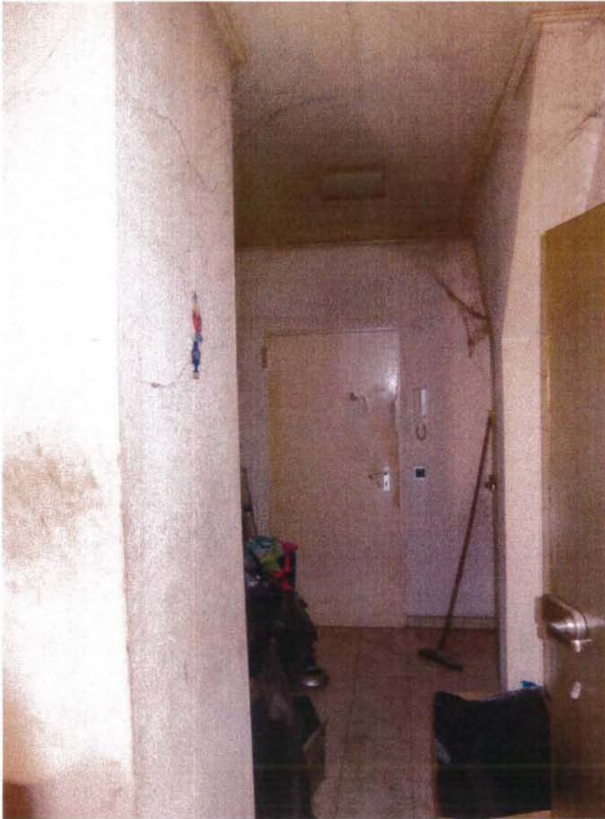
Abbildung(13) Flur im Hobbyraum Nr. 18 im Dachgeschoss des Hauses Graslitzer Straße 9.
