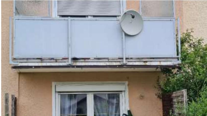
Dies weist auf eine undichte Balkonkonstruktion hin, die zu Korrosionsschäden an der Bewehrung führen kann.
