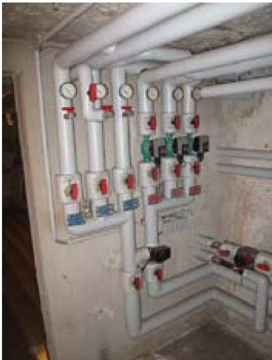
Verteiler-Heizkreisläufe 6 Einheiten, neu
