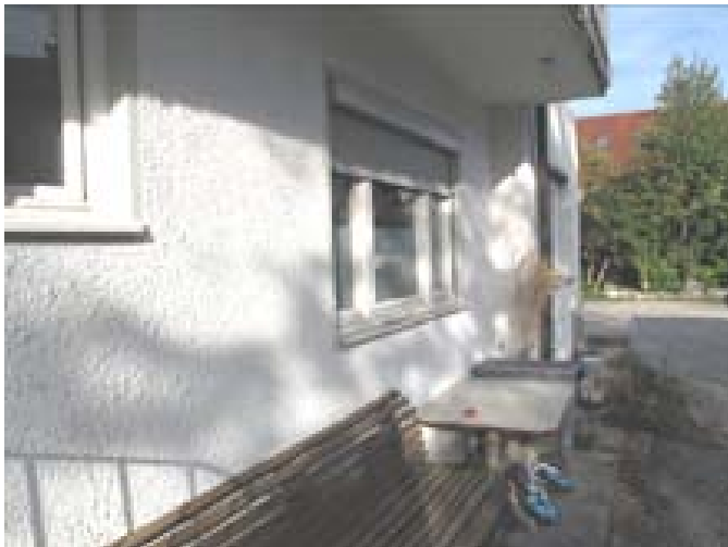
Rauhputz, weiß; Doppelverglasung/Holzkastenfenster zzgl. aufgesetzter Rollläden; fehlende Rollläden / DG-Fenster
