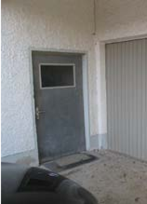
Zugang Keller am Garagen-Anbau
