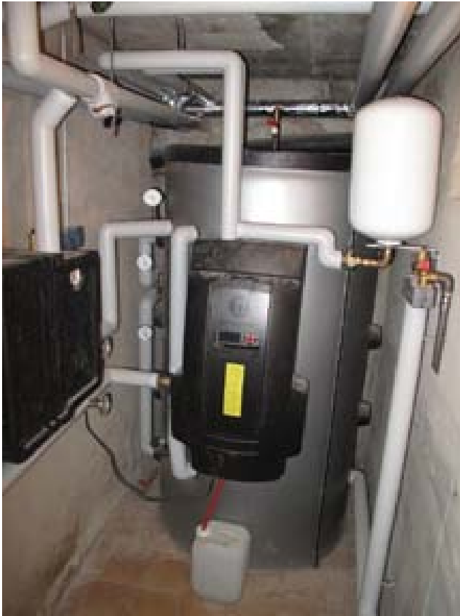
Solarboiler: solarthermische Warmwasser-Anlage / Pufferspeicher
