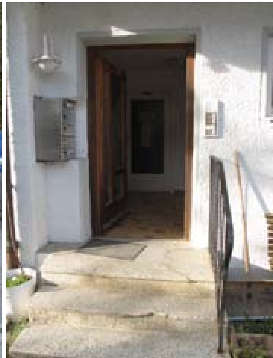
Steintreppe, 5 Briefkästen, Holzrahmentüre
