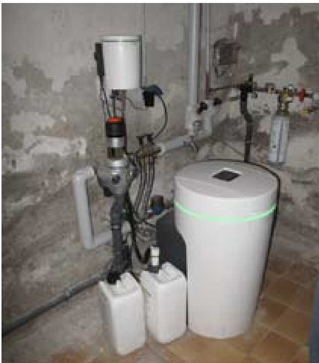
Entkalkungsanlage, neuwertig
