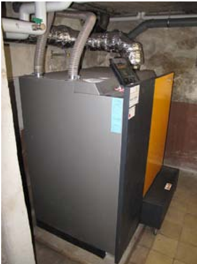
Holzpellet-Vergaserkessel mit Pellet-Ansaugereinrichtung Voll-/Fernsteuerung - Mikroprozessor; Baujahr: 2020
