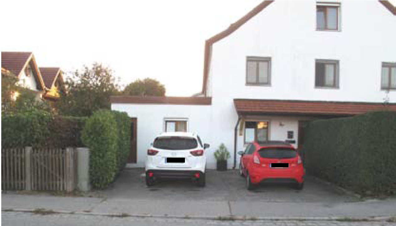
Separater Eingang der Erdgeschoss-/Gartenwohnung West (mit 2 Kfz-Stellplätzen davor)
