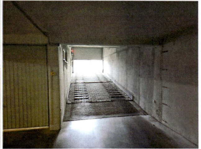
überdachte Rampe mit Ampelanlage
