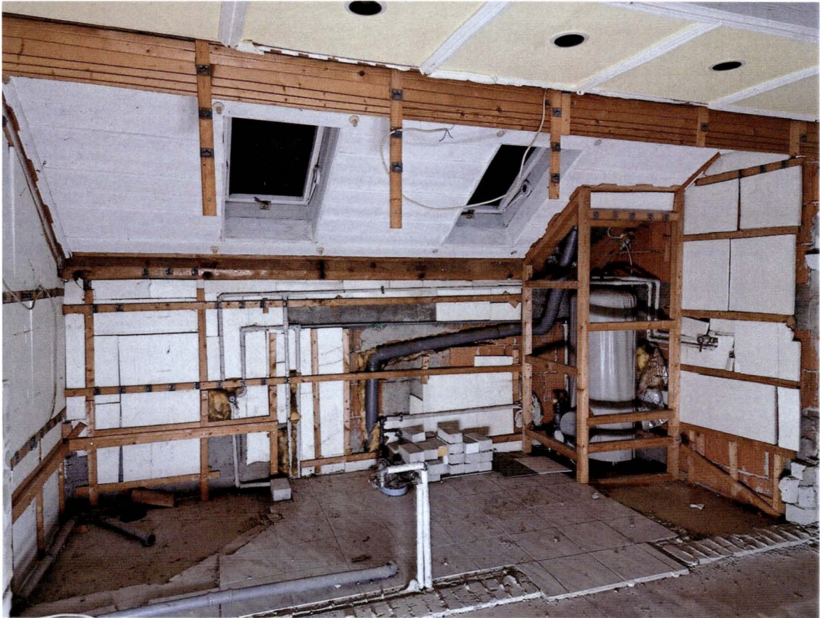
15 DG, Rohbau Badezimmer
