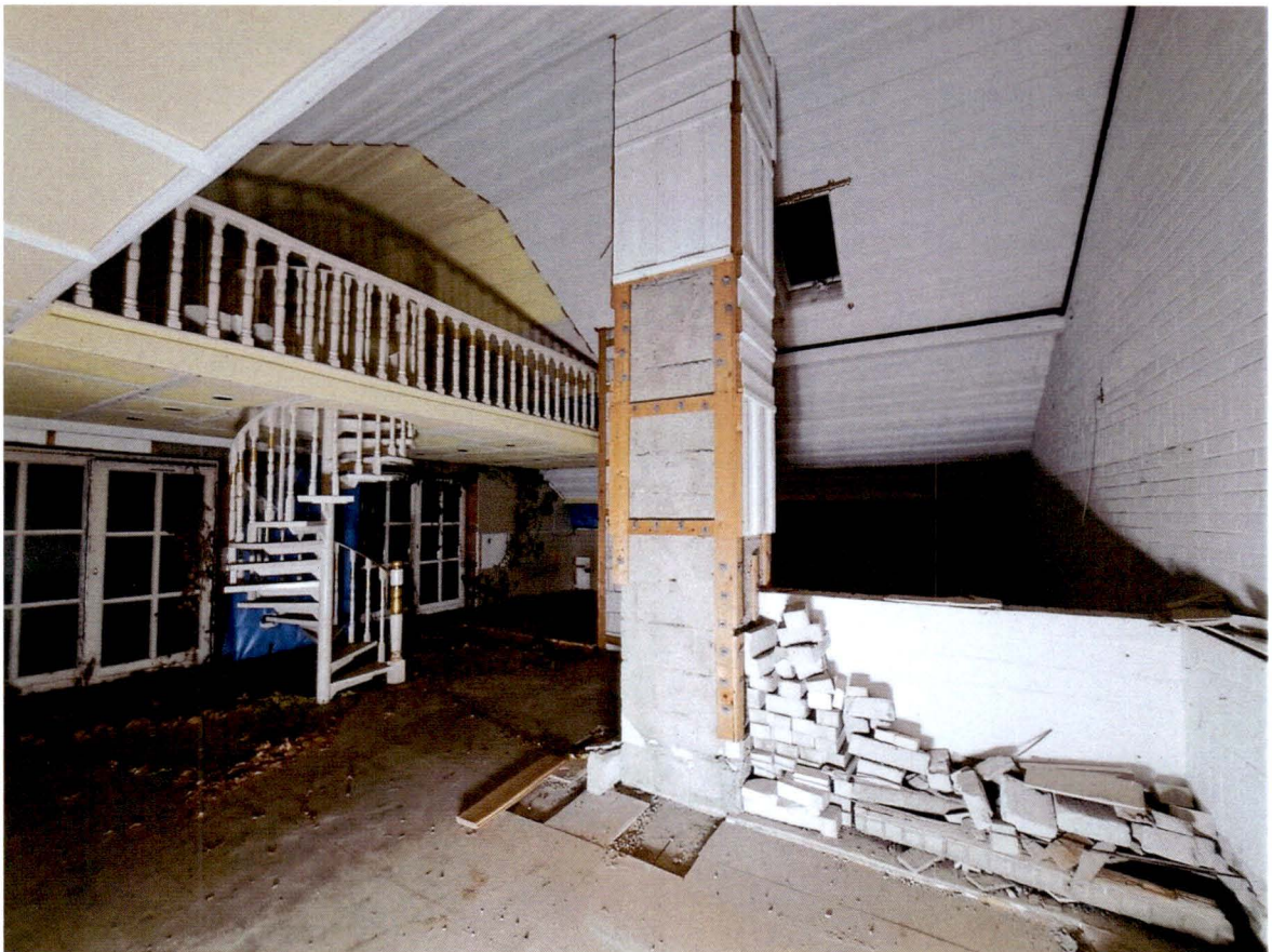
14 DG, Rohbau mit Galerie
