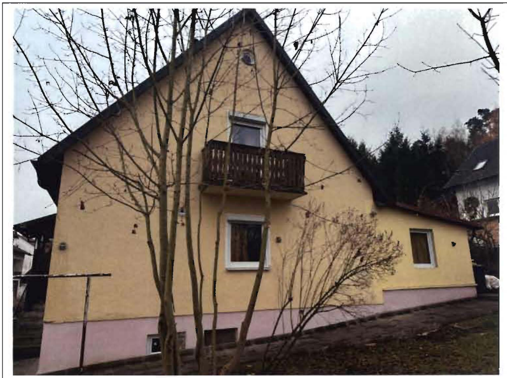
Foto 2: Ansicht von Westen
