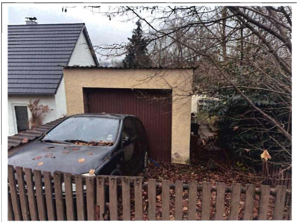
Foto 6: Garage – Ansicht von Süden
