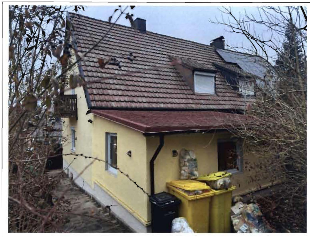
Foto 3: Ansicht von Südwesten
