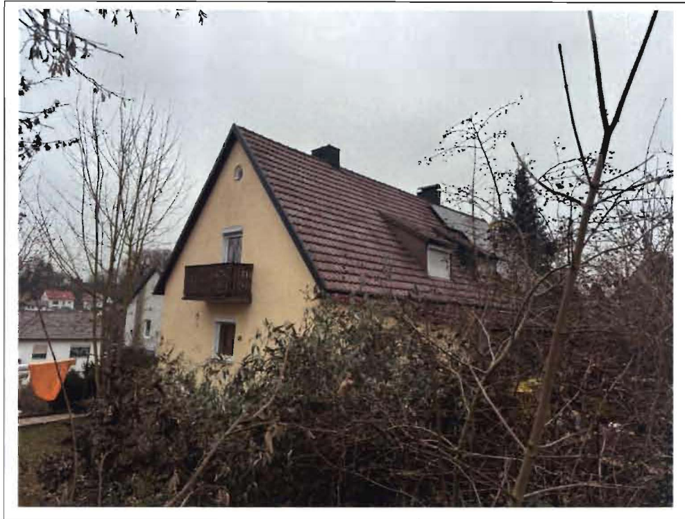
Foto 1: Ansicht von Südwesten
