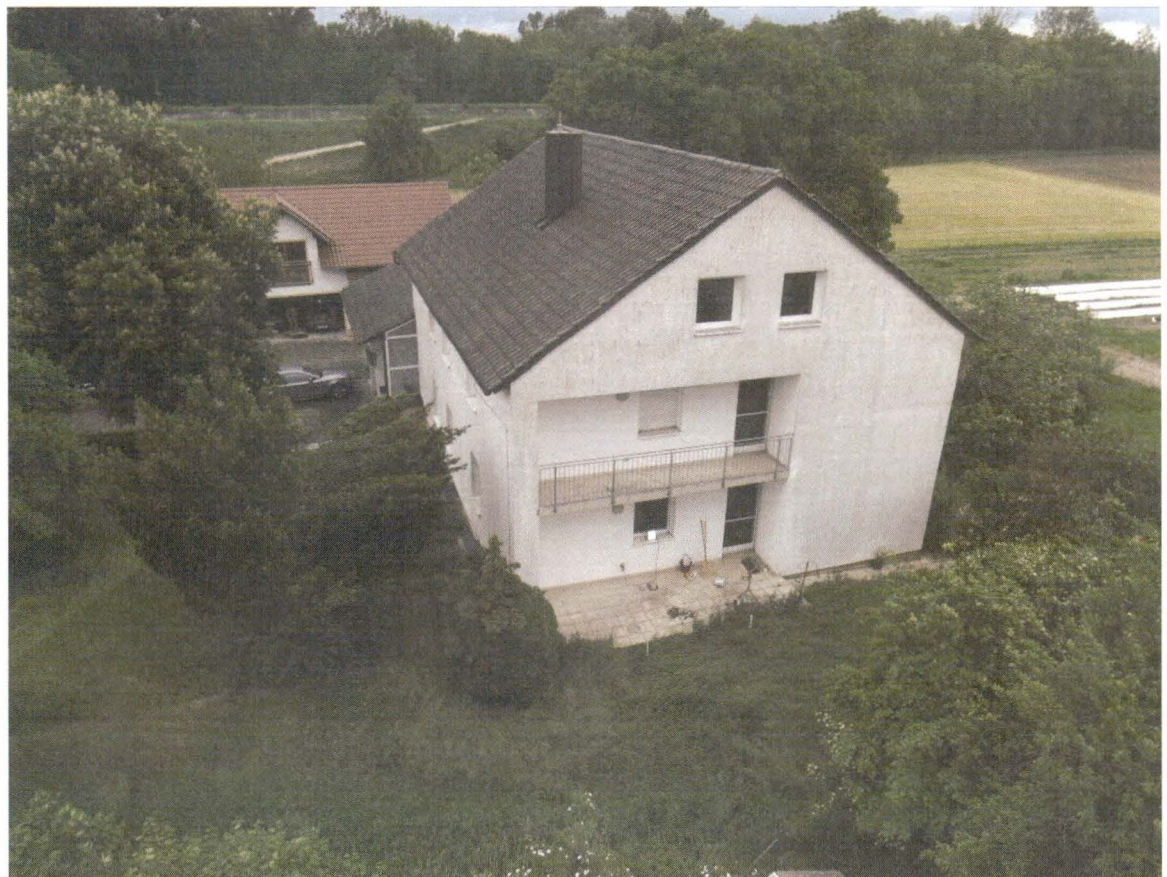
Südseite mit halb offener Terrasse vor der Küche und Wohnzimmer-Außentüre sowie im Obergeschoss mit Balkon/Loggia vor dem Küchenfenster der OG-Wohnung und Wohnzimmer-Balkon-Außentüre;
