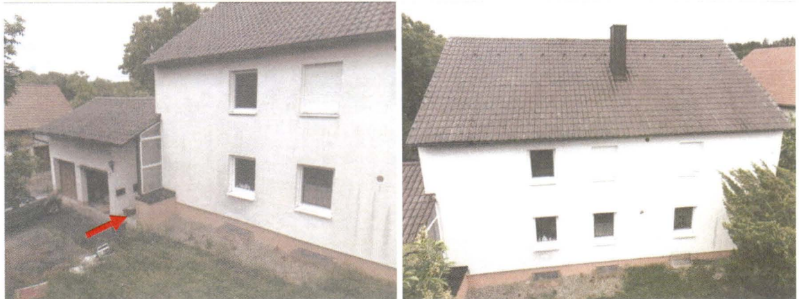
West-/Wetterseite mit Haus-Eingang (Rotpfeil) zw. Garage (links) und Haupthaus
