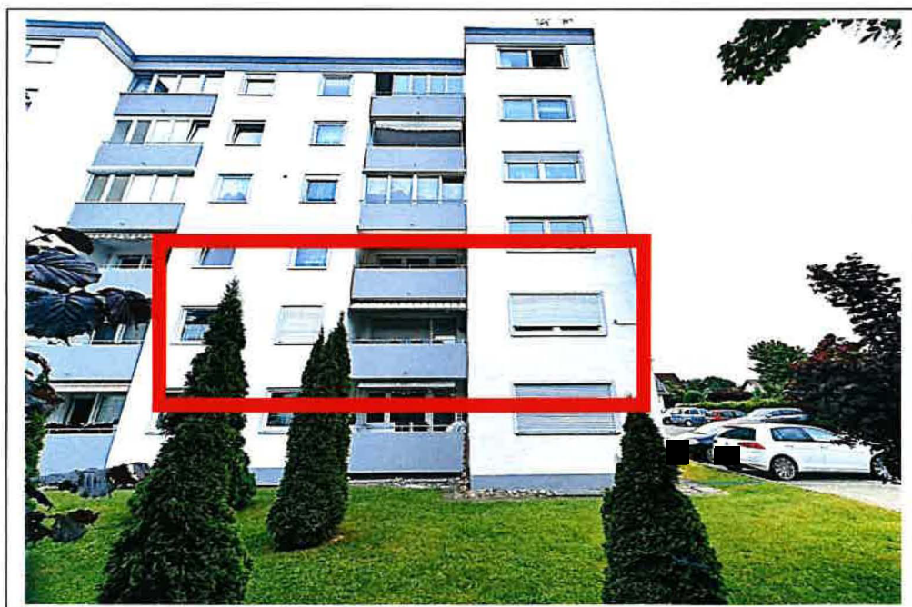
Foto 4: 89312 Günzburg, Ulmer Straße 67, Ansicht West
