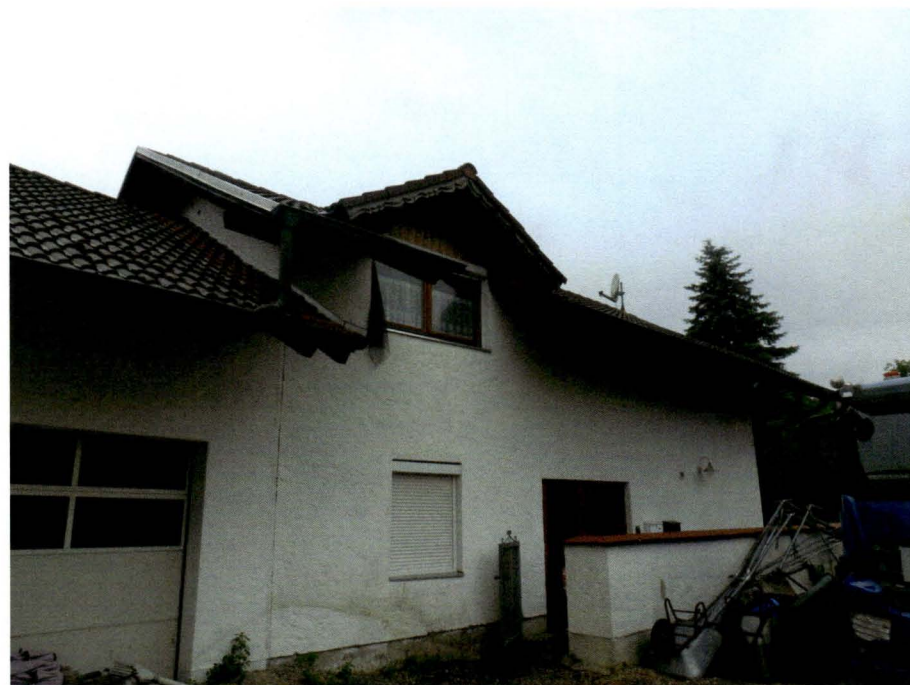
Blick von Nordosten auf das Wohnhaus Friedrich-Then-Weg 25
