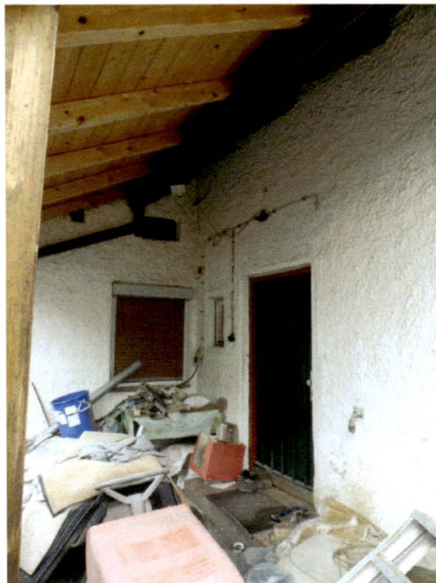
Blick auf den Zugang an der Südfassade des Wohnhauses Kolpingstraße 9
