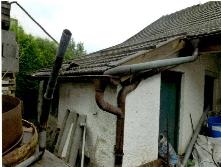
Blick von Südosten auf den südlichen Anbau des Wohnhauses Kolpingstraße 9
