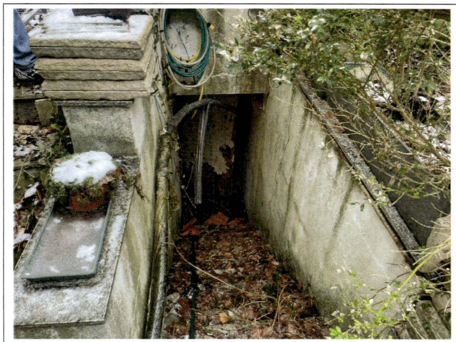
Foto 16: Treppe zur Garage
