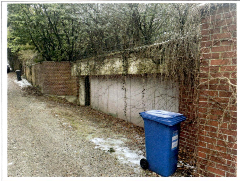
Foto 3: Garage - Ansicht von Nordwesten
