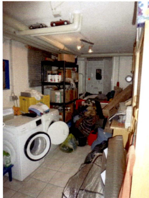
Heizung/Waschraum im KG
