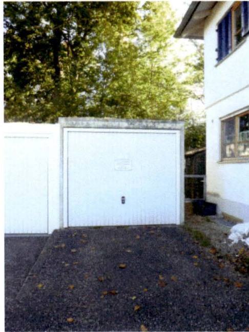
Westfassade Garage auf Flst. 718/30
